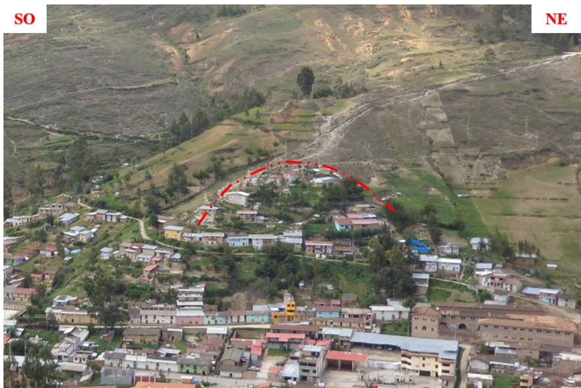
Foto 17. Delimitación del deslizamiento Dz-03 que se encuentra afectando las edificaciones
