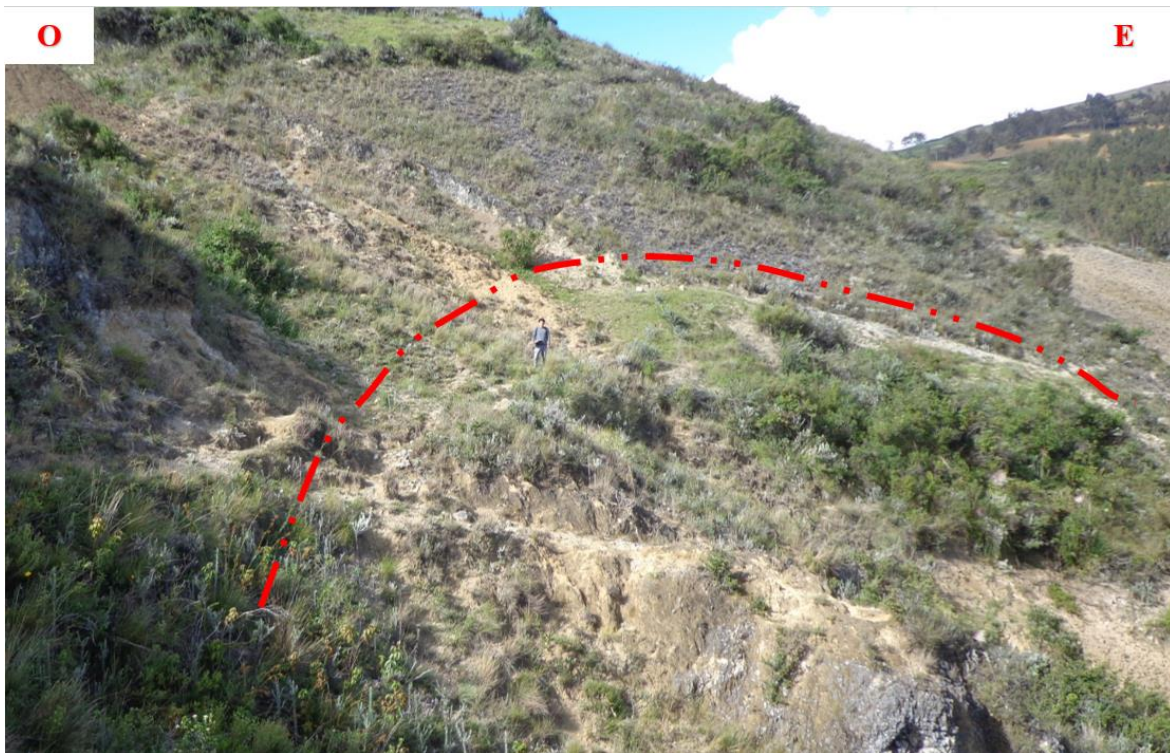
Foto 18. Delimitación del deslizamiento Dz-04 que se encuentra afectando las edificaciones
