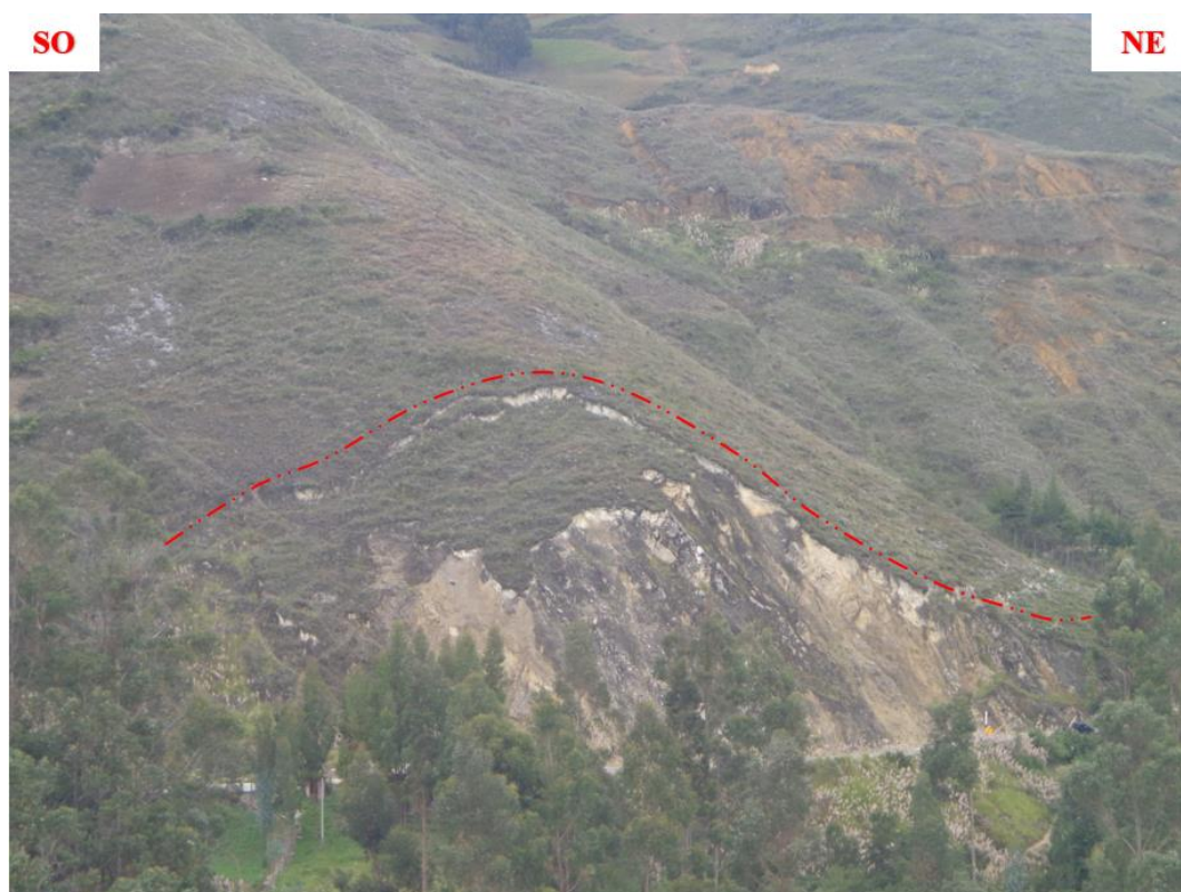
Foto 15. Delimitación del deslizamiento Dz-01 que se encuentra afectando el talud
