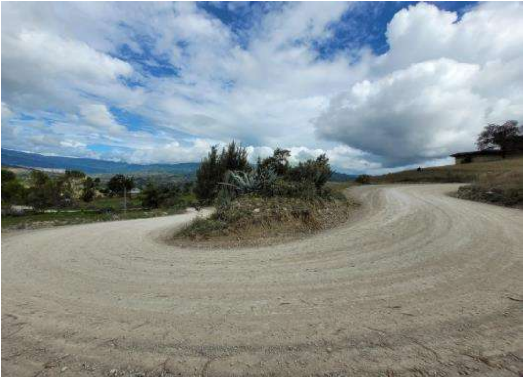
Figura N°17. Curva con radio menor a las permitidas.
