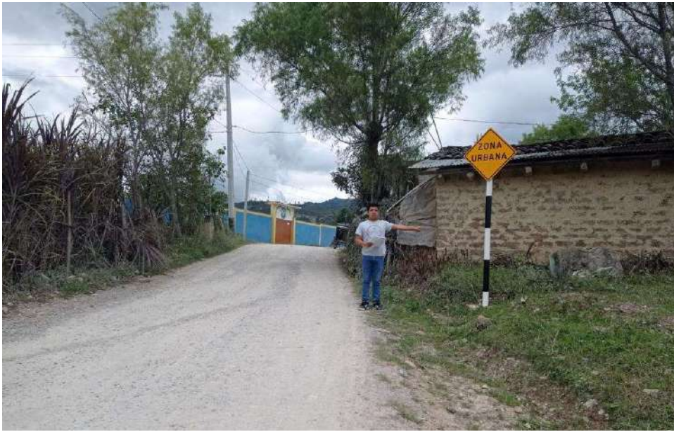
Figura N°19. Señal zona urbana – Km04+284m.
