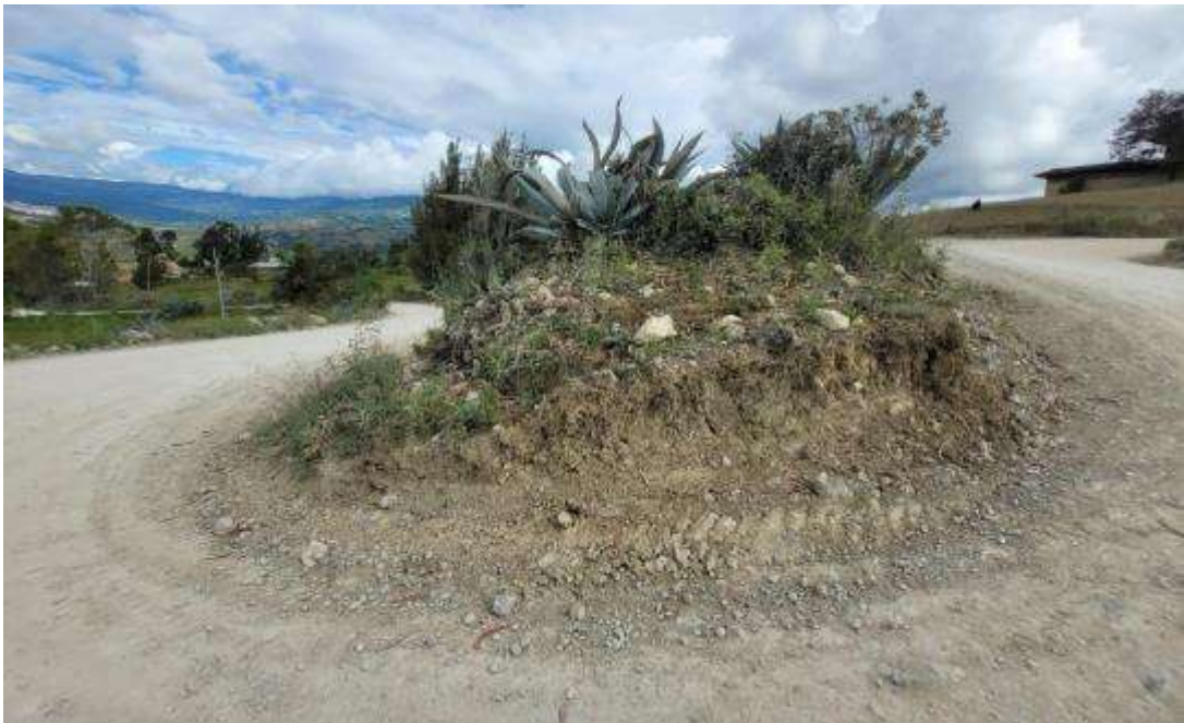
Figura N°18. Curva que no tiene el sobreebanco mínimo.
