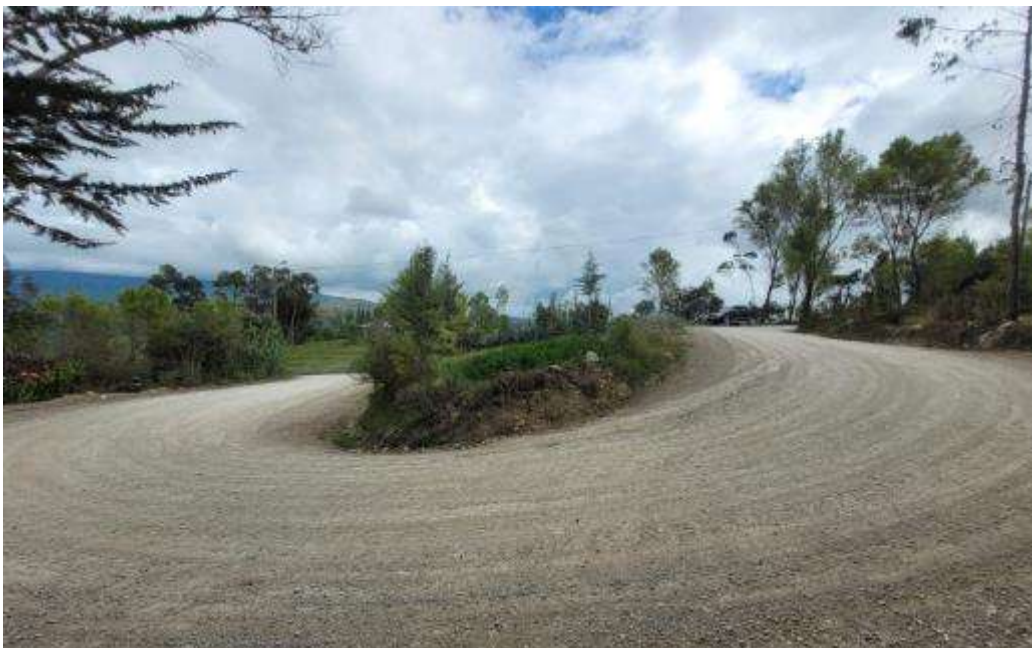
Figura N°16. Curva con radio menor a las permitidas.
