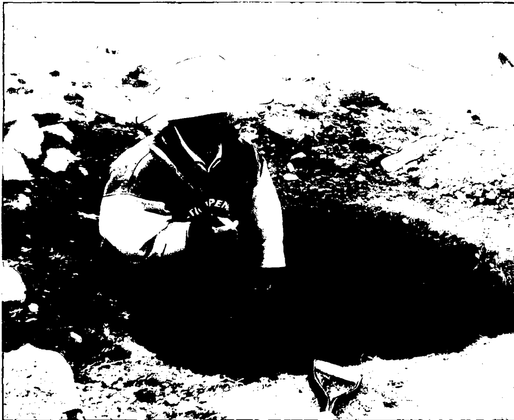
Excavación de calicatas
