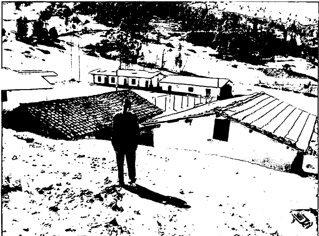
Punto de inicio del tramo II I.E 82872 Capulipampa Km. 05+000
