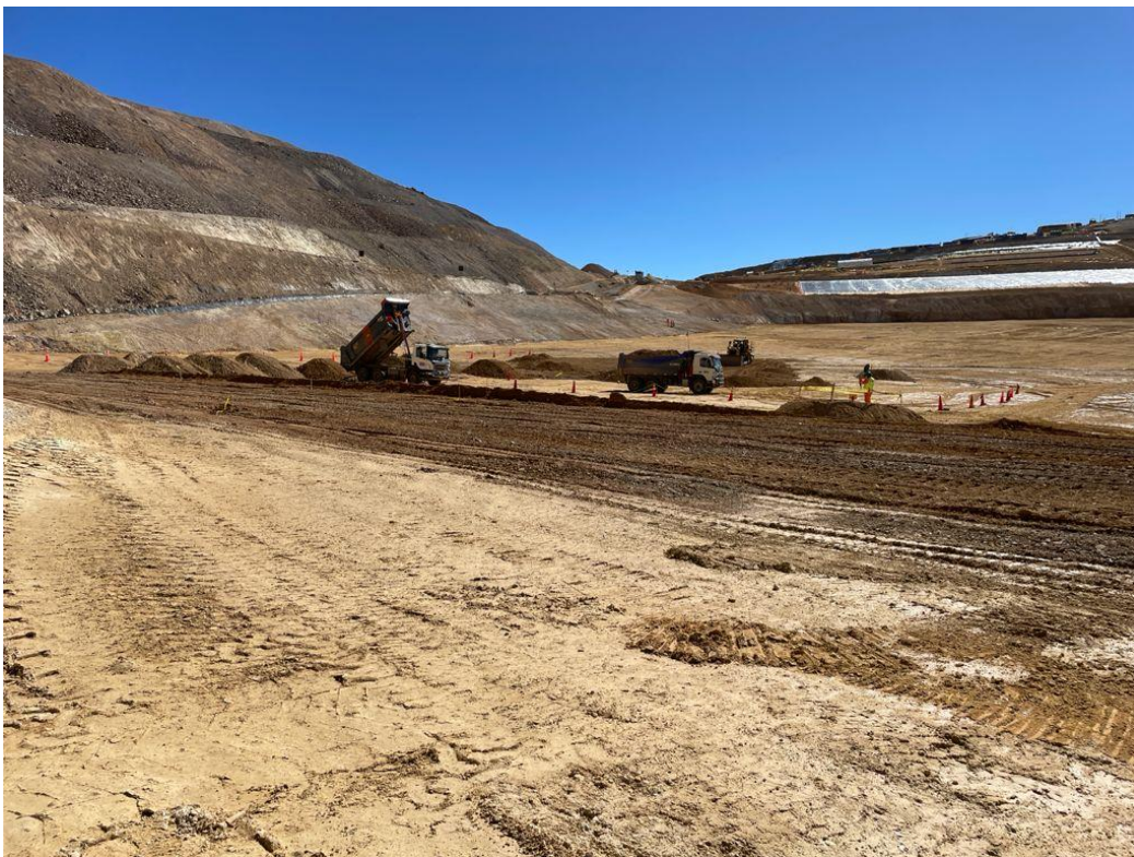
Figura 46. Descarga de mineral en la plataforma de lixiviación
