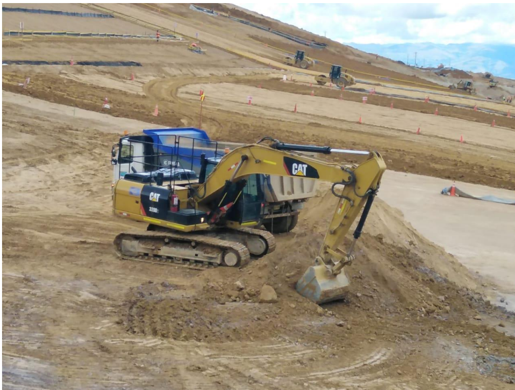
Figura 44. Excavadora Caterpillar 336 D2L
