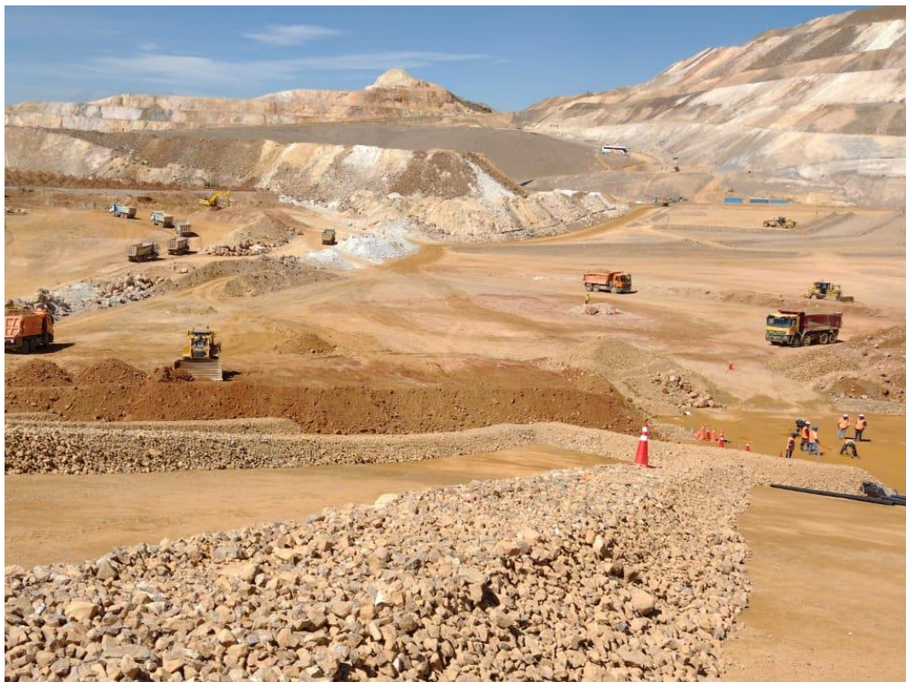
Figura 50. Acarreo, descarga y extendido del mineral para lixiviación
