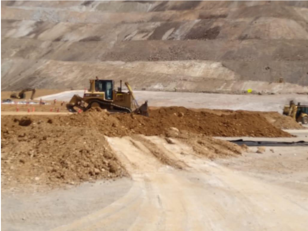
Figura 49. Empuje de mineral con el tractor Caterpillar D6T en la plataforma de lixiviación
