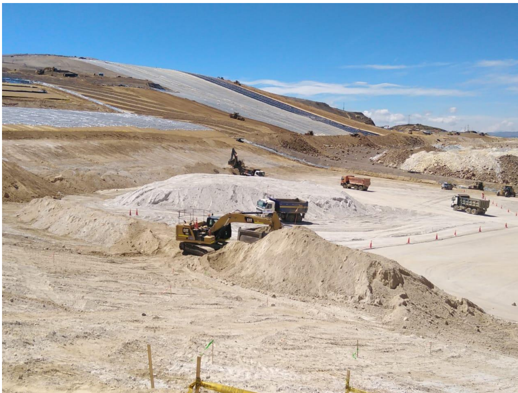
Figura 48. Carguío y acarreo del material para eliminación
