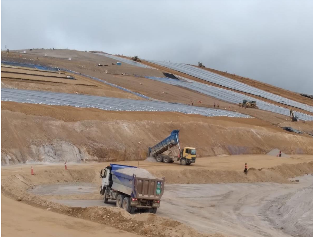
Figura 47. Acarreo de material en la construcción de la plataforma de lixiviación
