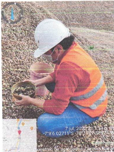
Obtención de Agregados Grava Chancada y Arena Chancada de la Cantera Bazán en Cajamarca Para elaboración de diseño Patrón y Diseños con polvo de caucho.
