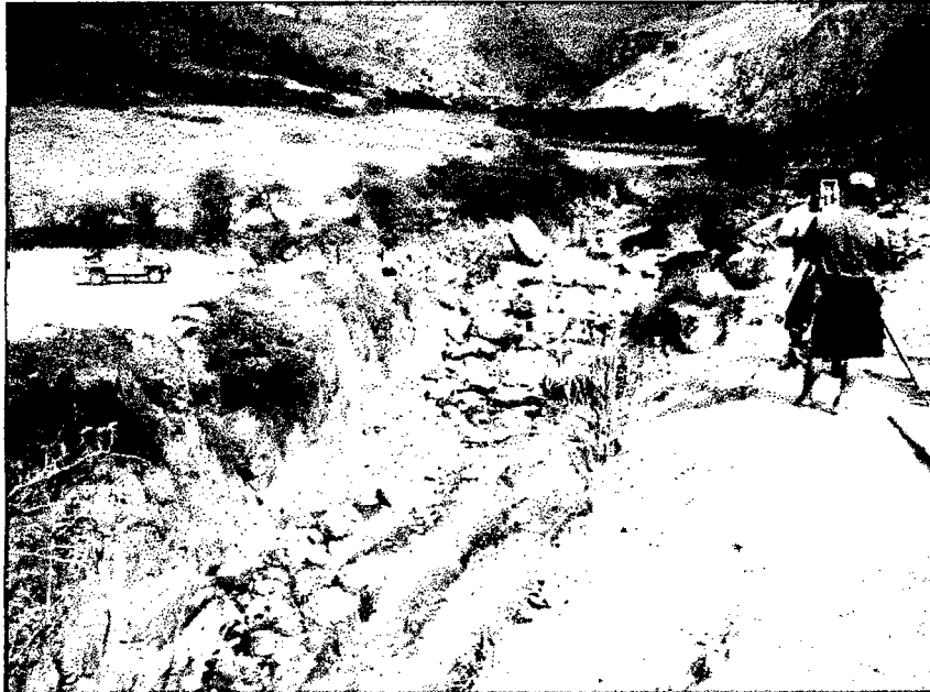
Levantamiento topográfico de la zona donde se está proyectando un puente, se observa claramente que es un cañón de paredes verticales, constituido por roca en sus dos extremos
