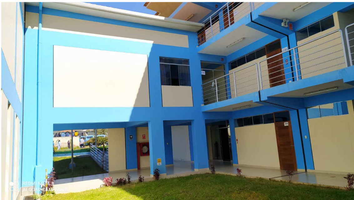
Fotografía N°02: Vista lateral del Módulo "C" de la Edificación de E.A.P "Turismo y Hotelería" de la Universidad Nacional de Cajamarca
