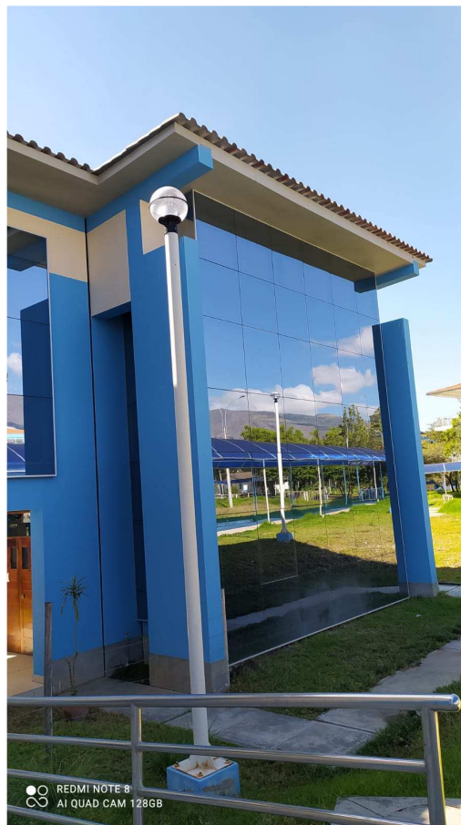
Fotografía N°04: Vista frontal del Módulo "D" de la Edificación de E.A.P "Turismo y Hotelería" de la Universidad Nacional de Cajamarca
