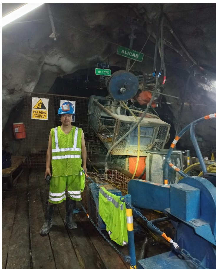
Foto 5. 1 Plataforma del equipo Alimak en labor – 2226
