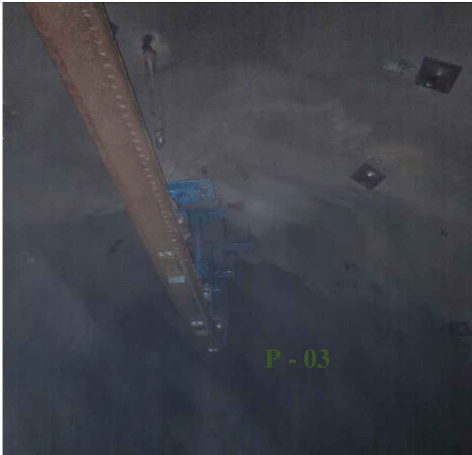
Foto 3. 3 Estación Geomecánica P – 03, con sostenimiento.
