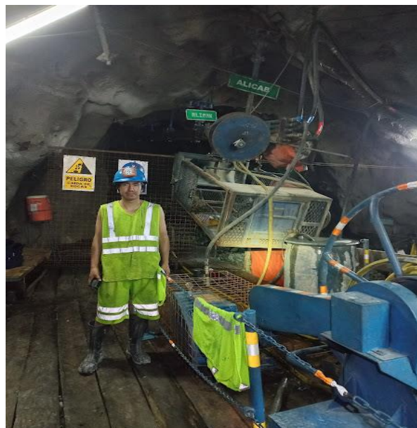
Foto 3. 6 Equipos de construcción de chimeneas Alimak
