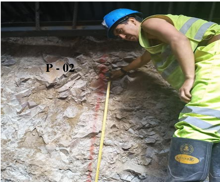
Foto 3. 2 Estación Geomecánica P – 02
