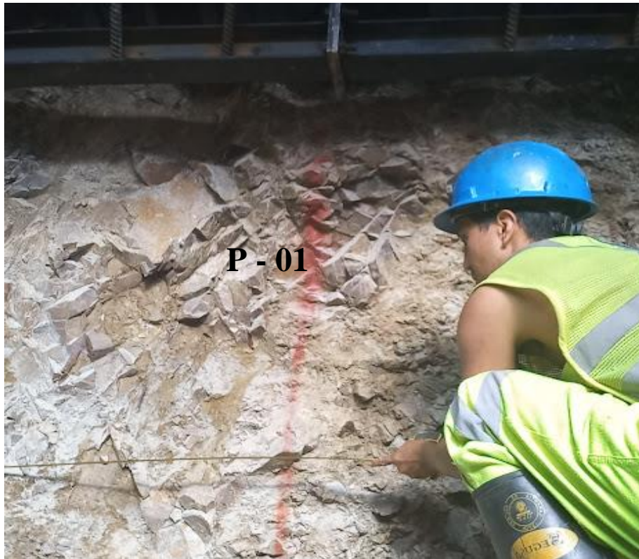
Foto 3. 1 Estación Geomecánica P – 01
