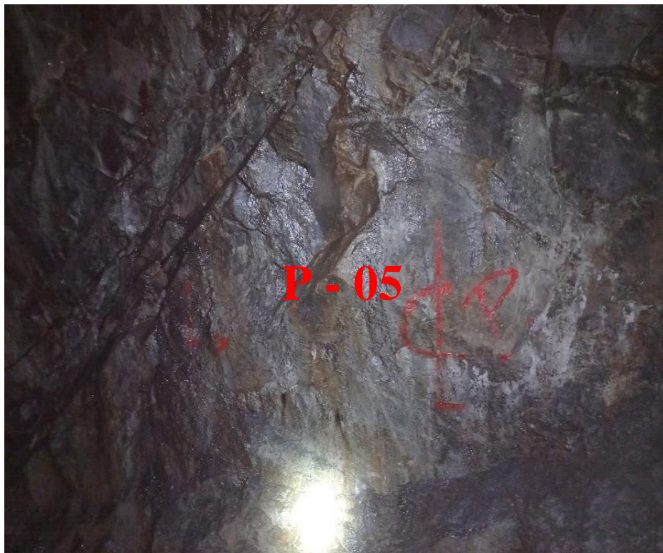
Foto 3. 5 Estación Geomecánica P – 05
