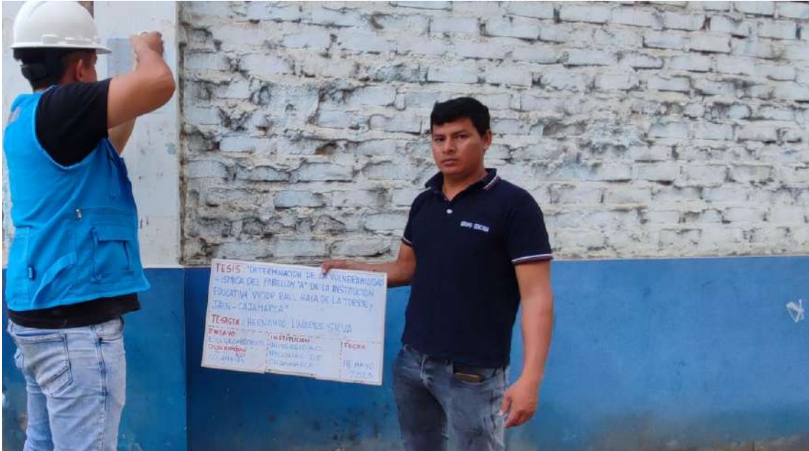
Foto 9: Realización de ensayo de esclerómetro en el Pabellón "A" de la I.E. Víctor Raúl Haya de la Torre.
