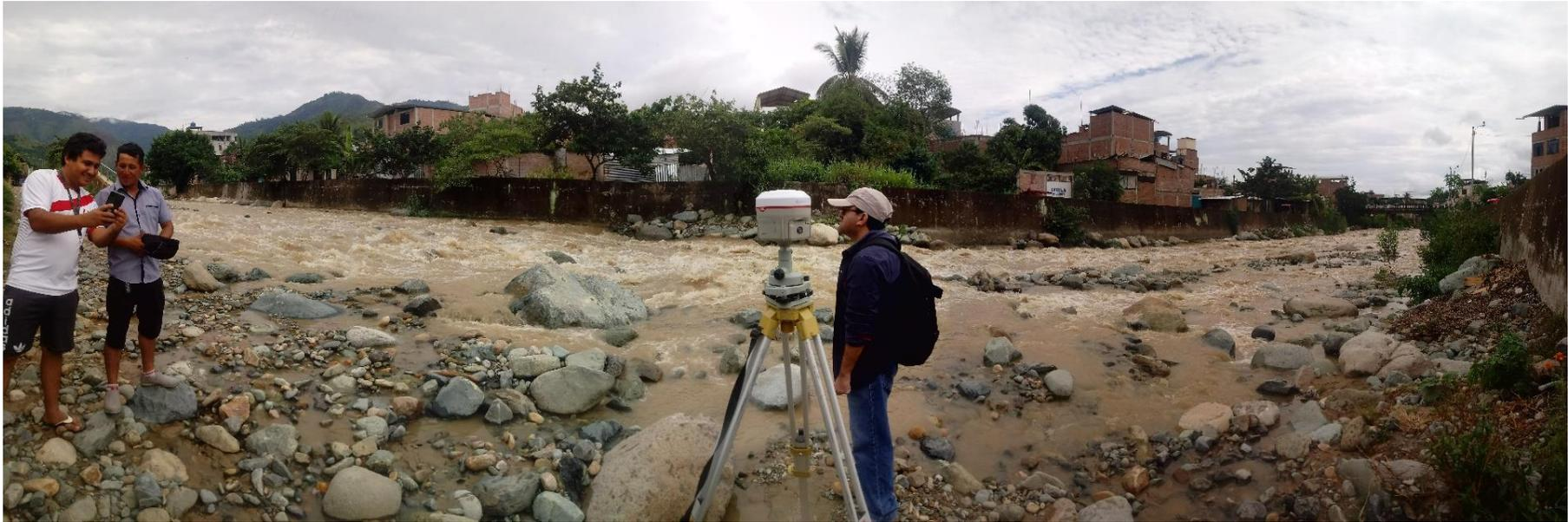
Fotografía 11. Levantamiento topográfico del sector El Parral –georreferenciación orilla de la quebrada Amojú
