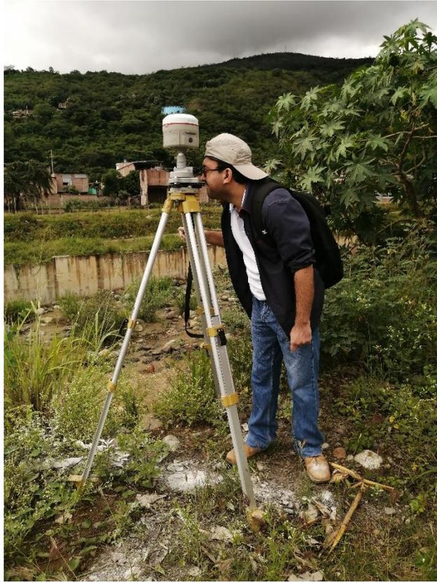
Fotografía 13. Levantamiento topográfico del sector El Parral –georreferenciación parte alta del sector. Al frente se observa muro de contención en el sector Monterrico – Los Bancarios
