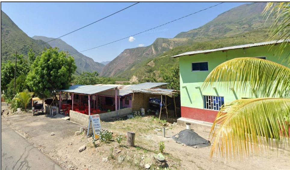
Fotografía 10. Viviendas ubicadas al margen derecho de la quebrada Cujaca y vulnerables a inundación.
