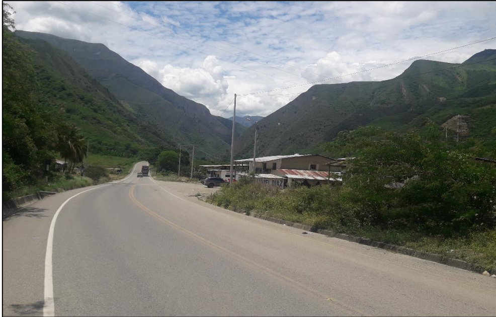
Fotografía 13. Muestra a la vía Fernando Belaunde Terry y las edificaciones expuestas a inundación en el margen izquierdo de la quebrada Cujaca.
