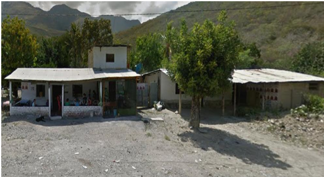
Fotografía 11. Edificaciones del margen del margen derecho de la quebrada Cujaca vulnerables a ala inundación.
