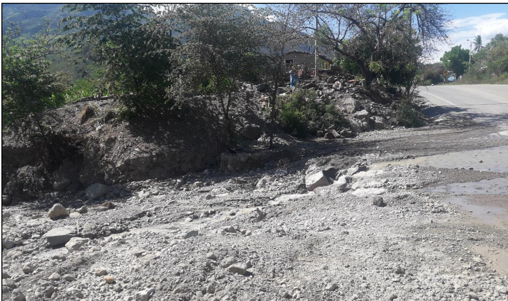
Fotografía 2. Muestra el badén existente en la vía FBT y el cauce de la quebrada Cujaca aguas abajo.
