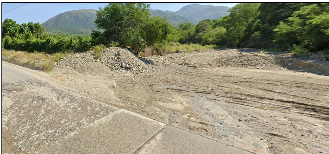
Figura 34. Proceso de descolmatación del cauce de la quebrada Cujaca
