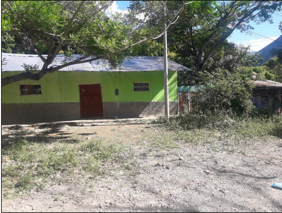
Fotografía 7. Vivienda de adobe inmersa en el área de inundación.
