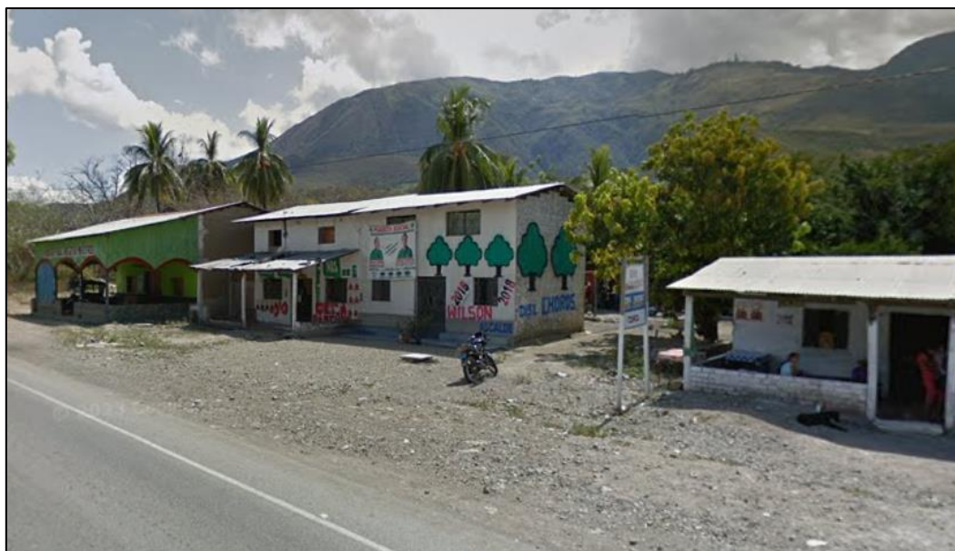
Fotografía 12. Edificaciones del margen derecho de la quebrada Cujaca, vulnerables a la inundación.
