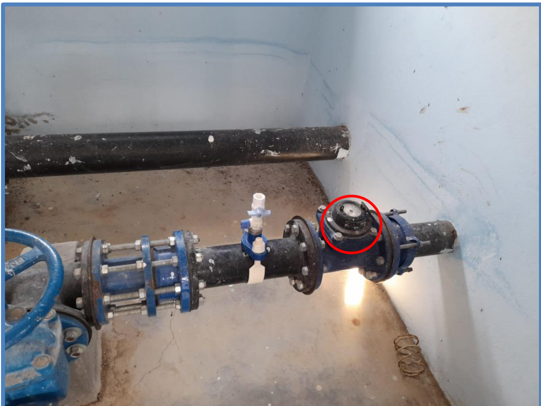
Foto 4: Ubicación del macromedidor en el reservorio.
