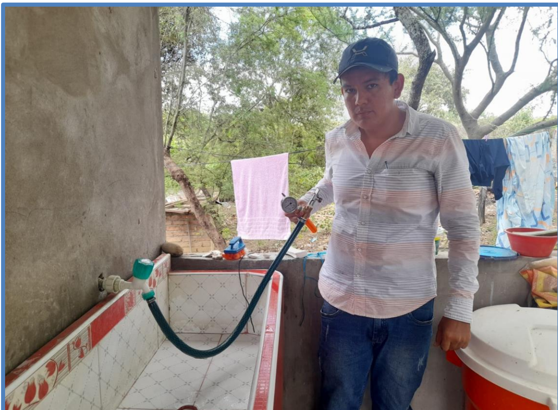
Foto 10: Medición de presión en los domicilios.
