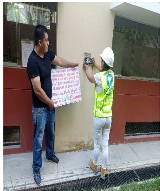
Foto 04: Ensayo de esclerometría en Columna T – N° de esclerometría E-12.
