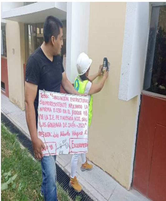
Foto 07: Ensayo de esclerometría en Columna T- N° de esclerometría E-9.
