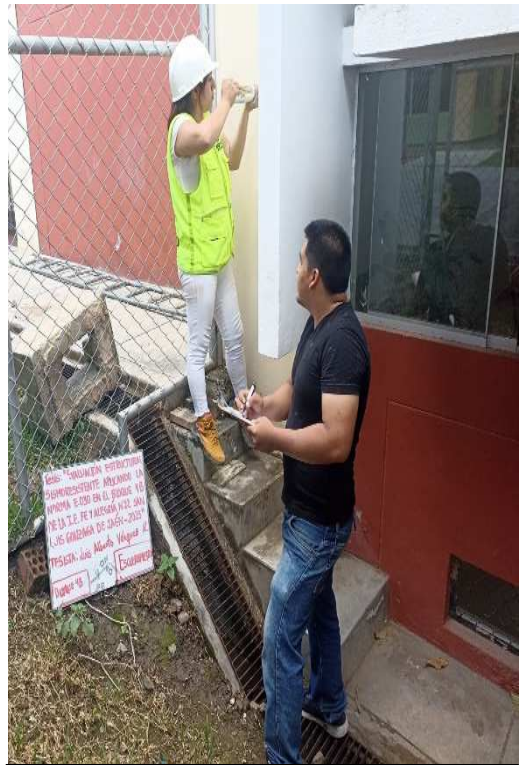
Foto 02: Ensayo de esclerometría en Columna L – N° de esclerometría E-14.
