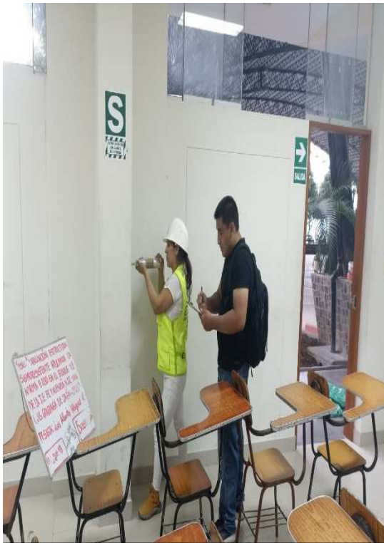
Foto 01: Ensayo de esclerometría en Columna T – N° de esclerometría E-5.
