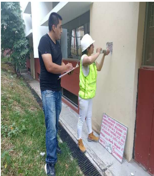
Foto 03: Ensayo de esclerometría en Columna T – N° de esclerometría E-13.
