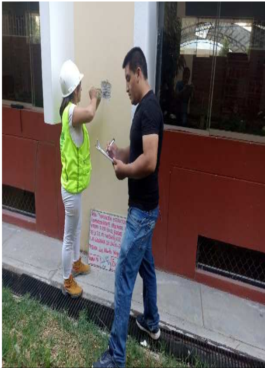
Foto 05: Ensayo de esclerometría en Columna T- N° de esclerometría E-11.
