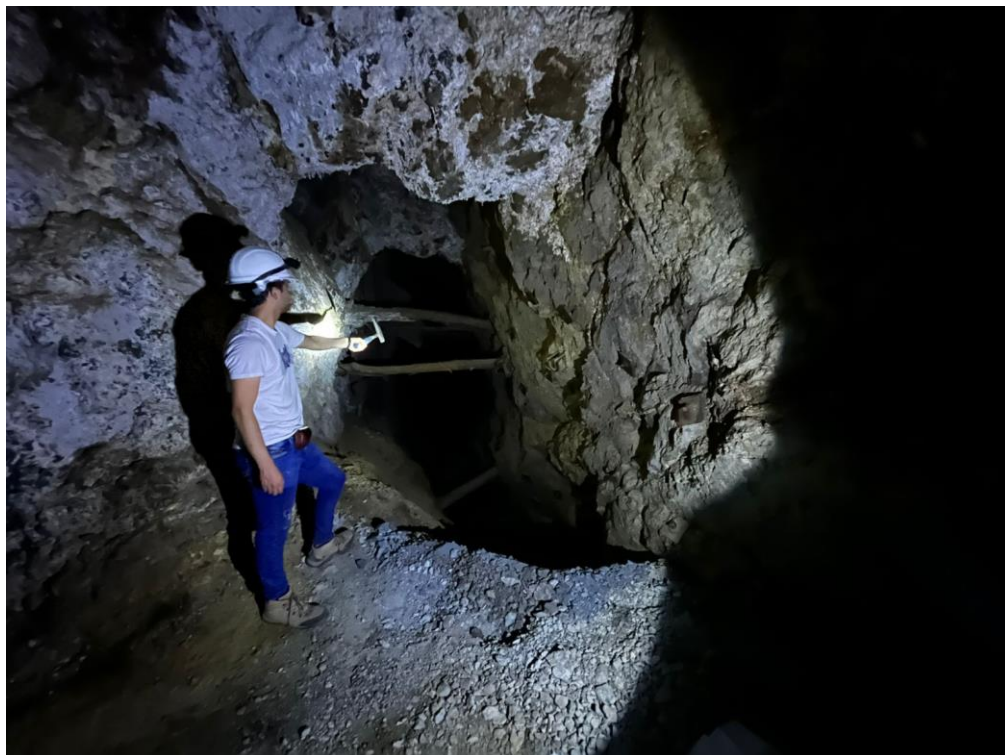
Figura 3.46. Zona tajada de la Veta Murciélago, desde el Pl. + 490 m. hasta Pl. + 609.20 m., formando una cavidad sub-vertical que une el Nivel 4 y 5, autosostenida ambas cajas por: Puntales y anclajes fricción (Split set y mecánico).
