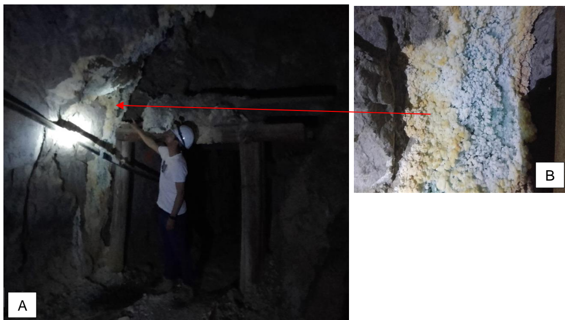
Figura 3.16. A. Flujo de agua en la clave de la labor discurriendo por el hastial derecho formando mineral hidrocincita por la humedad constante. B. Recristalización de hidrocincita con ancho de 0.30 m., con hábito botroidal, ubicado en el PI. + 145.45 m.
