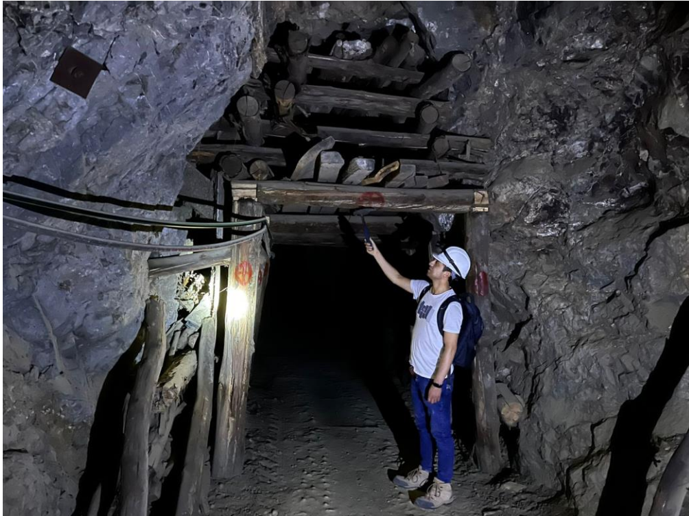
Figura 3.45. Sostenimiento por cuadros de madera rectos, de sección cuadrada: 0.25 m x 0.25 m. acompañados de emparrillado y acostillado, ubicado en el Pl. + 190 m.
