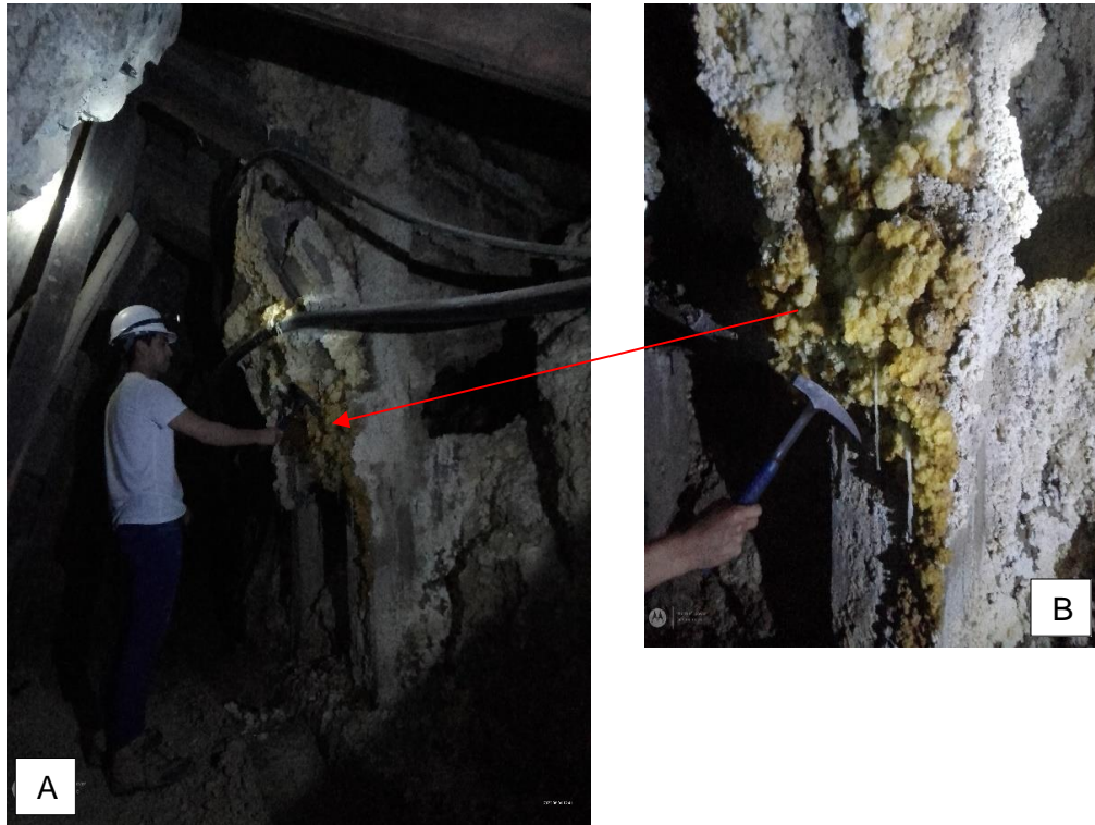
Figura 3.18. A. Zona de afectación de humedad constante desde Pl. + 190 m. llegando hasta Pl. + 200 m., afectando a la tolva, sobre todo en la margen derecha de la labor. B. Los minerales que se originan son: Epsomita e hidrocincita, con hábitos: botroidal a estalactitas.
