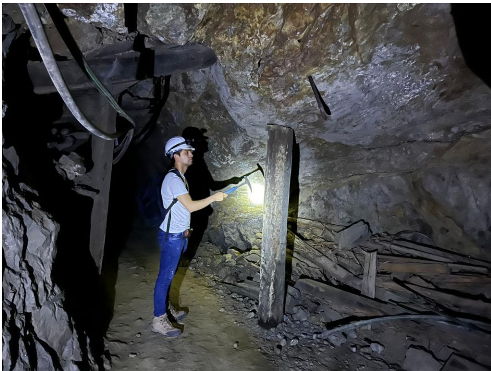
Figura 3.48. Puntal con dimensiones: 0.30 m. x 0.30 m. y longitud 2.20 m.; ubicado en el PI. + 477 m. del hastial izquierdo, soportando la carga de la clave.
