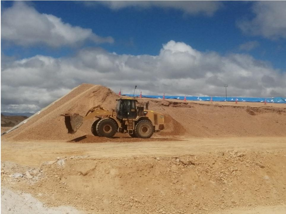
**Imagen 1.** Mezclado de la muestra de suelo con maquinaria
