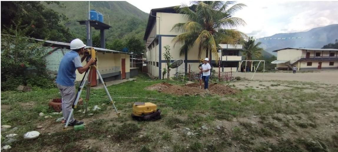
**Figura 22** Levantamiento topográfico de toda la I.E. 16 543 Leoncio Prado
