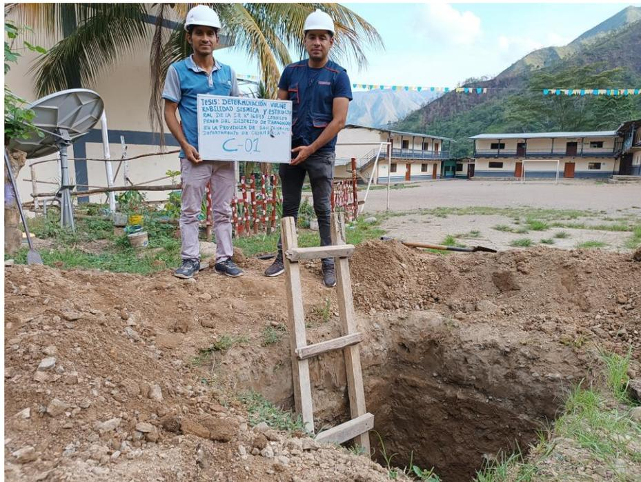
**Figura 26** Verificación de la medida de la calicata C-01 de 3 metros de profundidad
