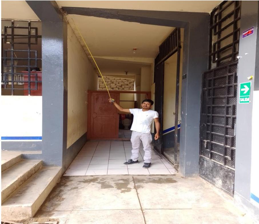
**Figura 17** *No hay presencia de junta sísmica de bloque a bloque*
