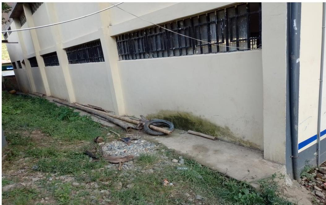
**Figura 13** *Medida de los alfeizares para verificar posible falla de columna corta*
