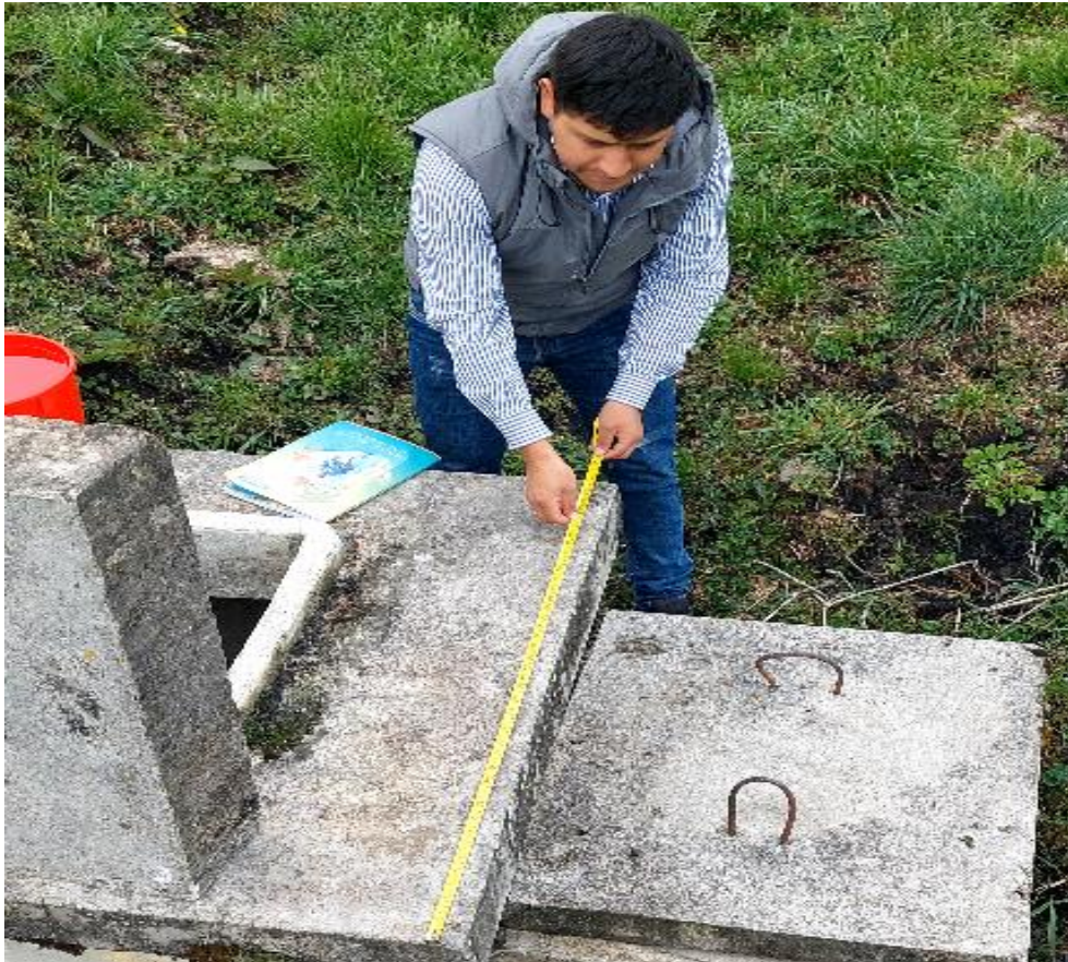
Foto 01: Verificación del estado y medición de la captación “el chorro”.
