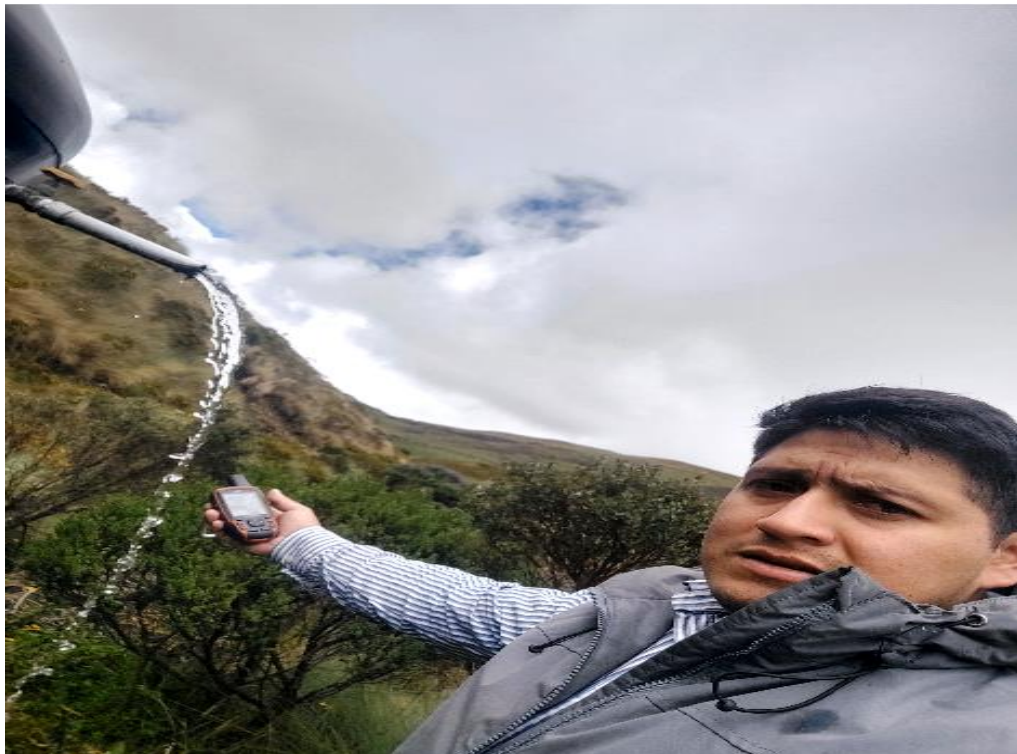
Foto 04: Exceso de agua (Rebose del reservorio).
