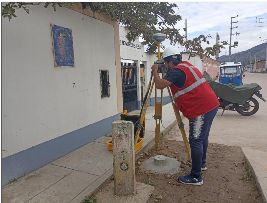
Figura 13: Ensamblaje del equipo GPS Diferencial Trimble R8S en placa geodésica punto C
