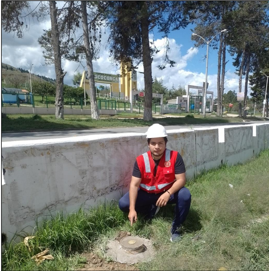
Figura 7: Colocación de placas en el Punto A en la altura del cruce de Iscoconga – Jesús
