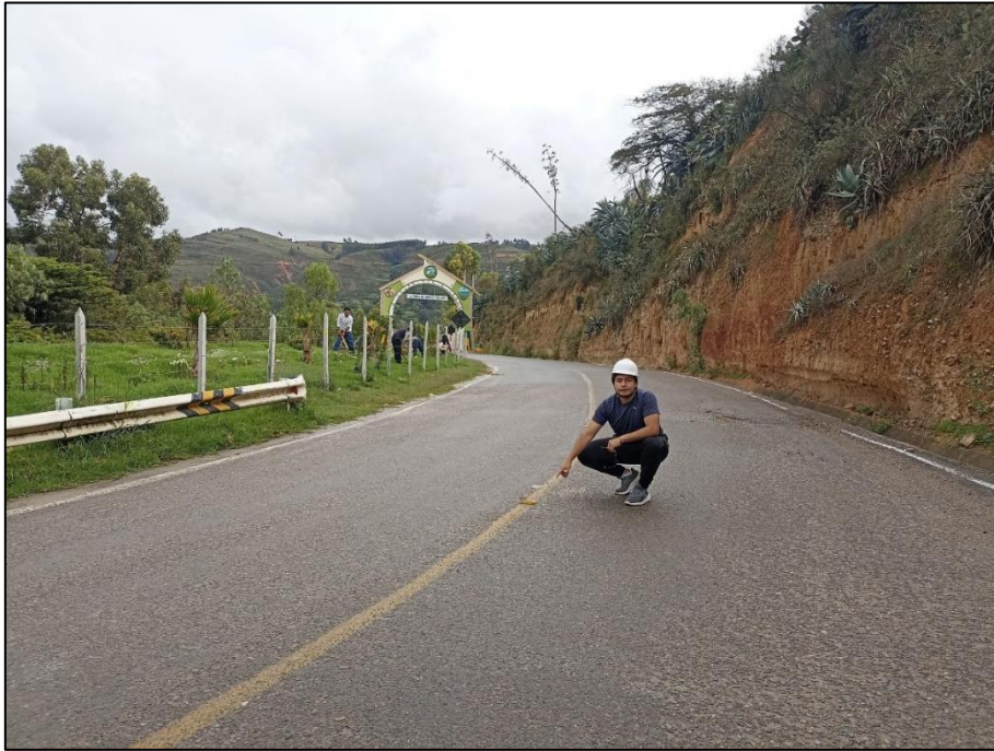
Figura 31: Toma de medidas con eclímetro en el Km 9+600
