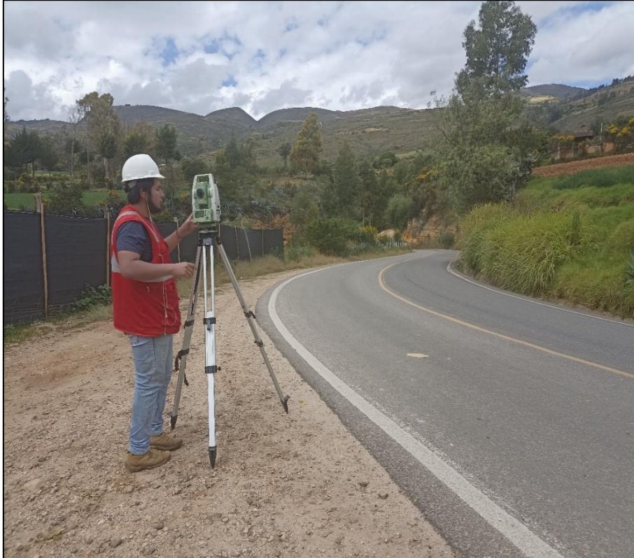
Figura 25: Levantamiento topográfico carretera Iscocongá – Jesús Km 8+710
