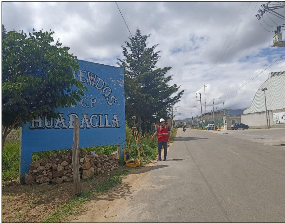
Figura 12: Registro de datos con GPS Diferencial punto B en la altura del Tramo Km 5+120
