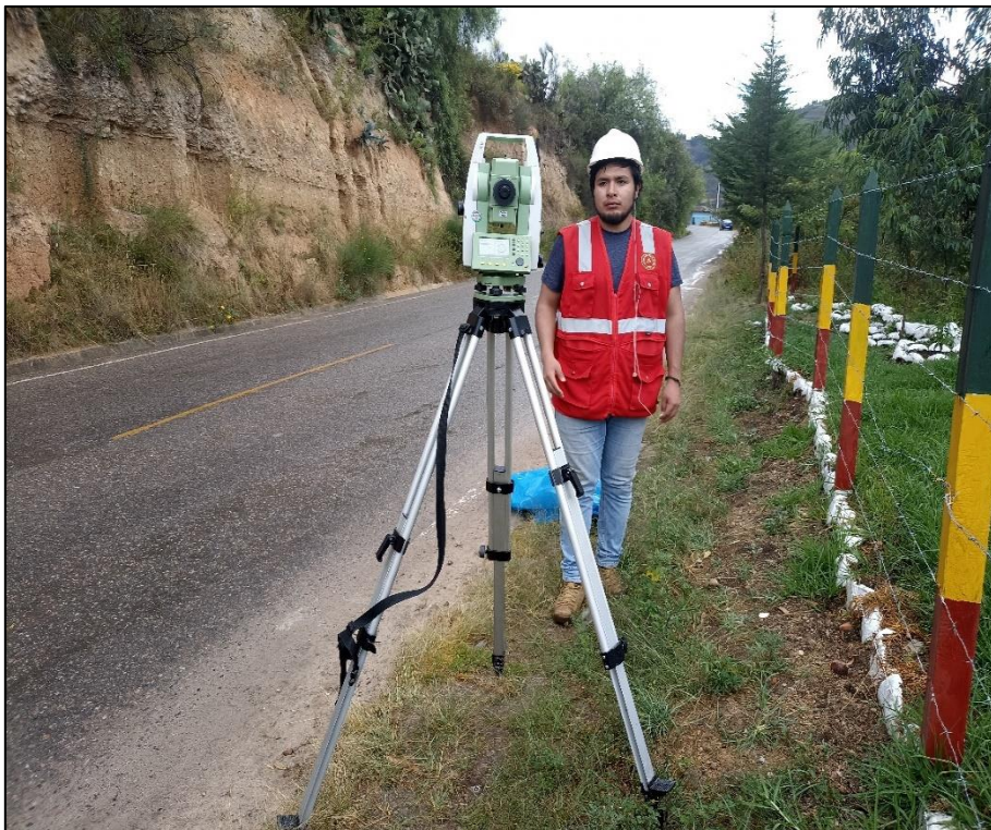
Figura 24: Levantamiento topográfico carretera Iscocongá – Jesús Km 8+240
