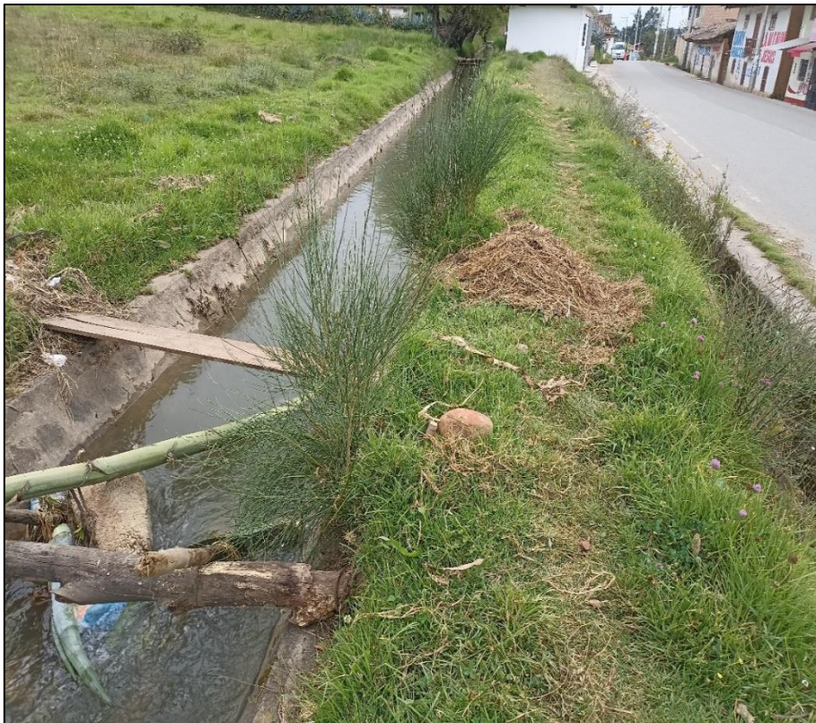
Figura 34: Canal abierto que cruza carretera en el km 5+080
