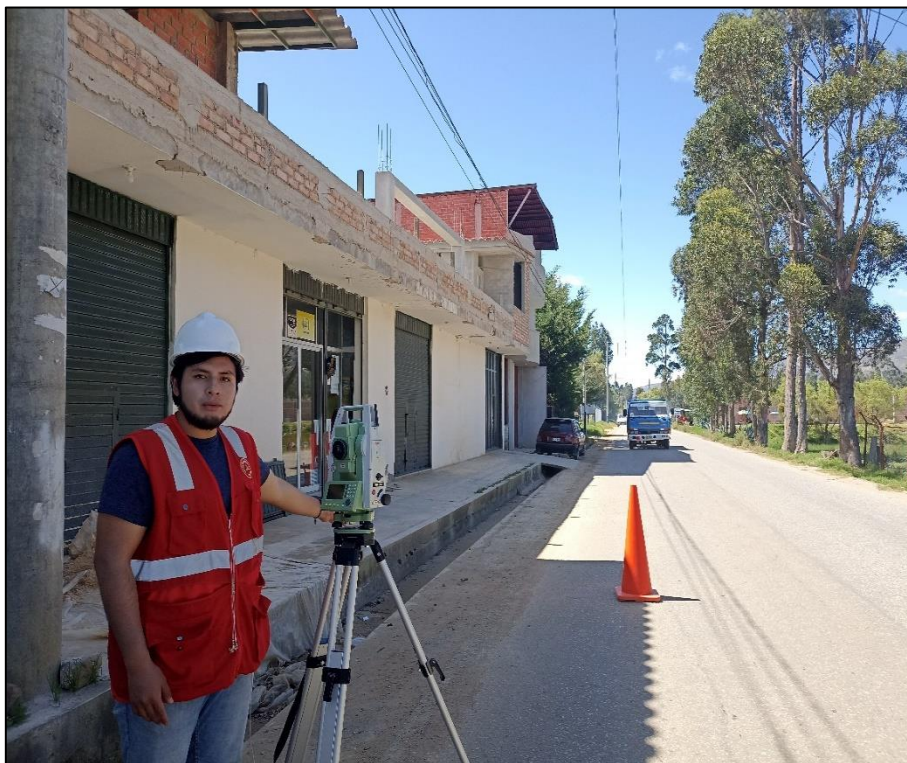
Figura 16: Levantamiento topográfico carretera Iscocongá - Jesús Km 2+440
