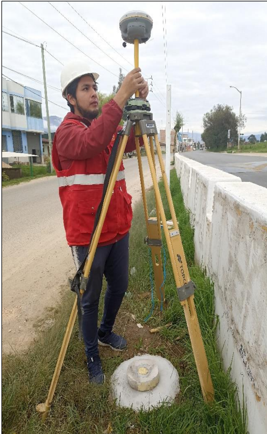
Figura 9: Ensamblaje del equipo GPS Diferencial Trimble R8S en placa geodésica punto A
