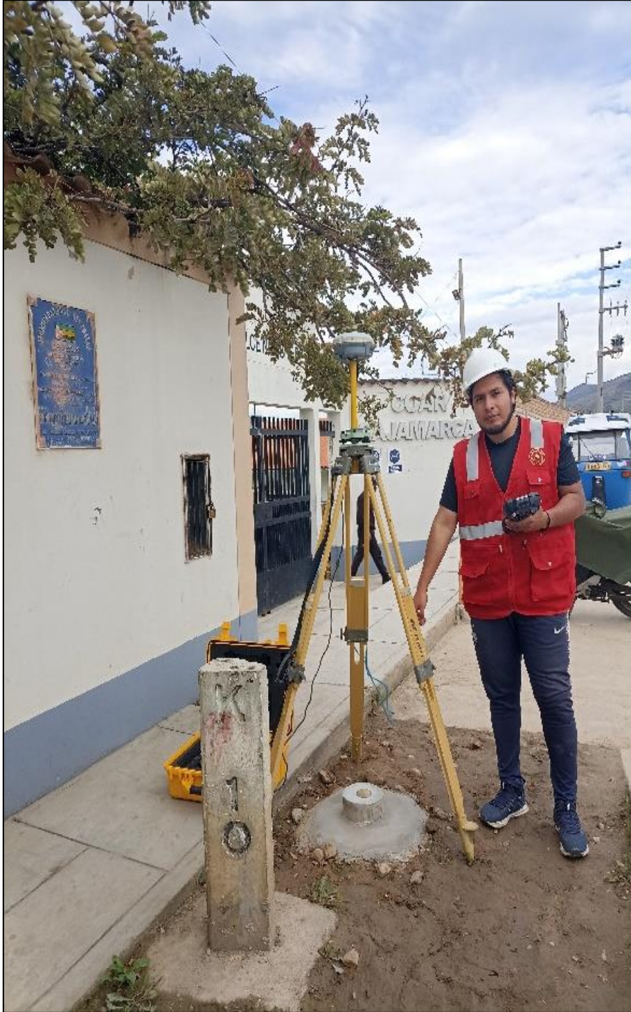
Figura 14: Registro de datos con GPS Diferencial punto C en la altura del tramo Km 10+020
