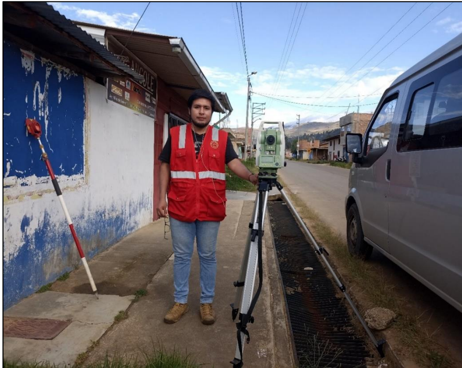
Figura 21: Levantamiento topográfico en carretera Iscocongá – Jesús km 5+420
