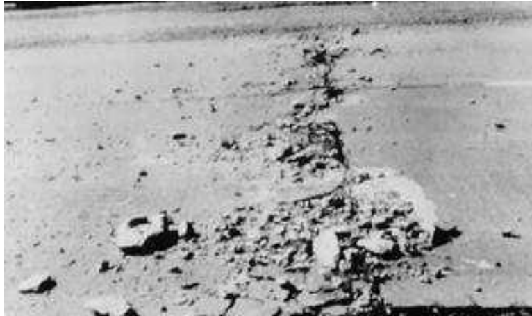
Figura 3 Levantamiento/Pandeo – Mediana Severidad
