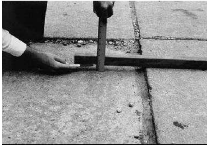
Figura 16 Escalonamiento – Mediana Severidad
