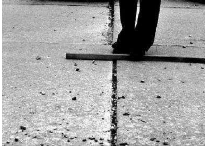
Figura 14 Escalonamiento – Baja Severidad
