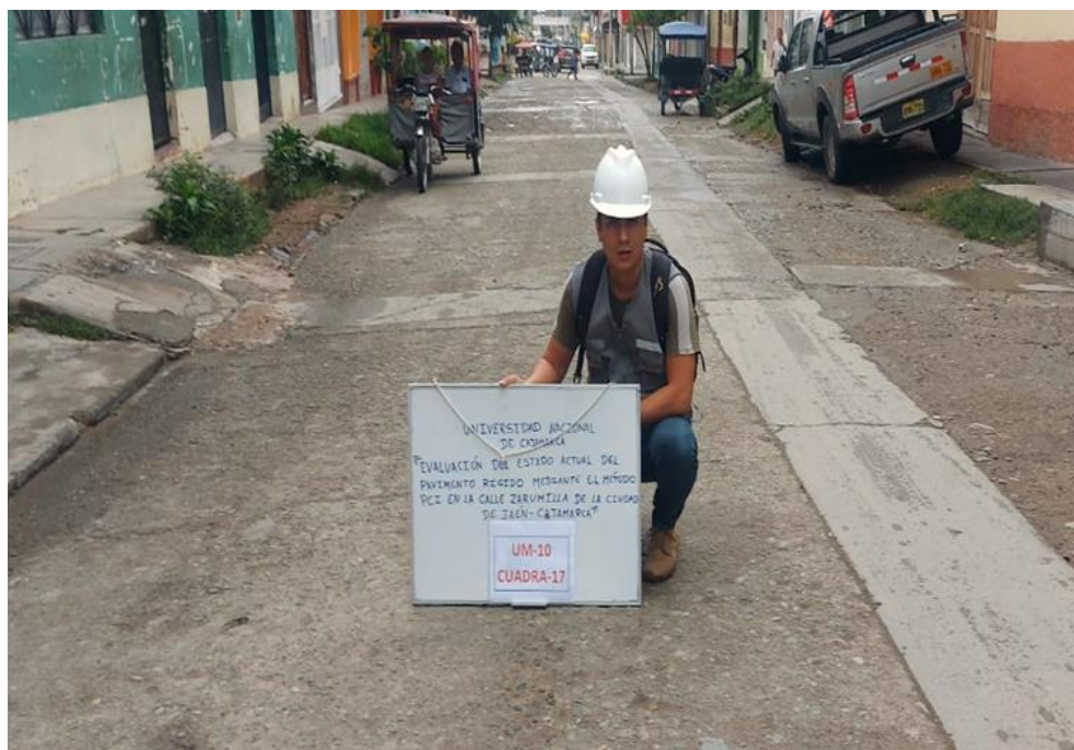
Figura 112 Inspección de las fallas en la unidad de muestreo 10 de la cuadra N° 17 entre la progresiva 0+074.60 – 0+079.70
