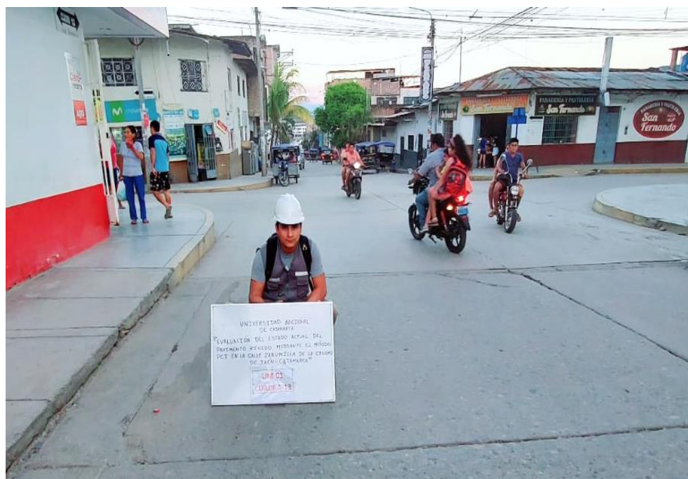
Figura 101 Inspección de las fallas en la unidad de muestreo 01 de la cuadra N° 13 entre la progresiva 0+006.05 – 0+009.10.
