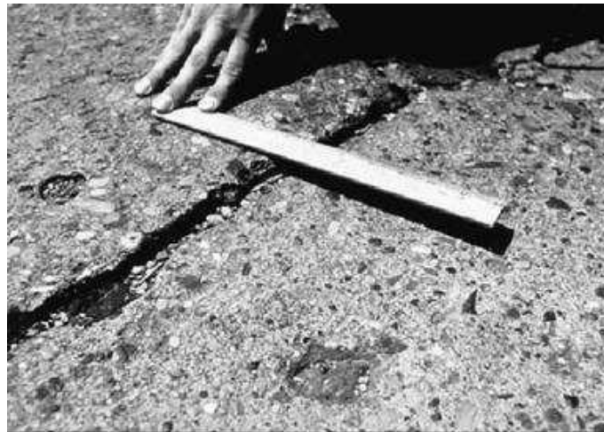
Figura 15 Escalonamiento – Mediana Severidad
