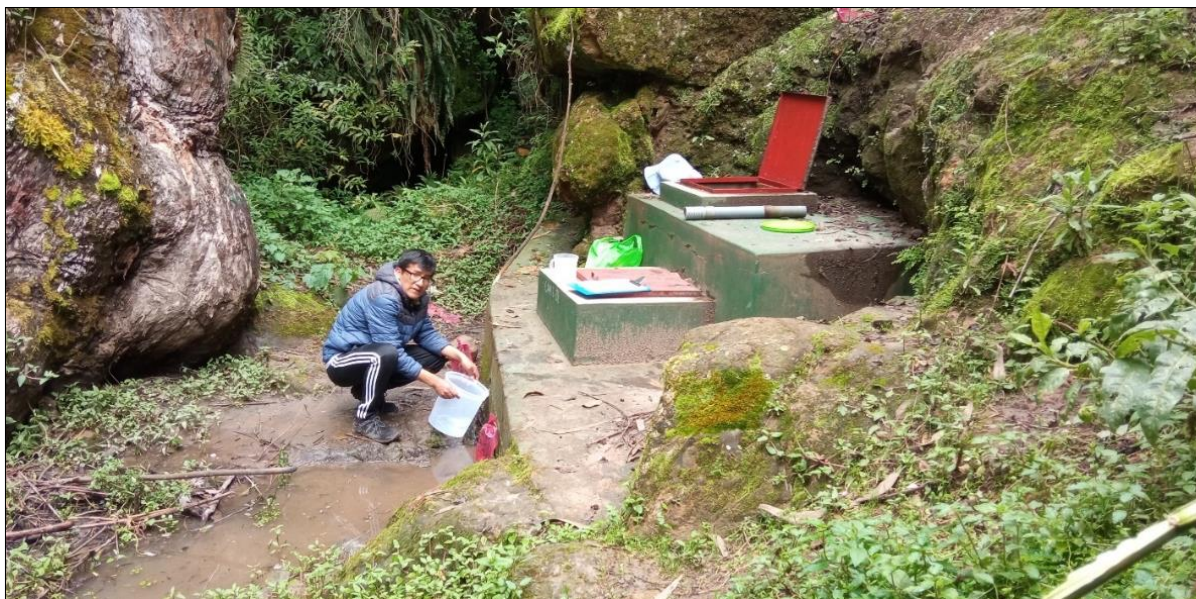
Figura 18: Aforo de captaciones.
