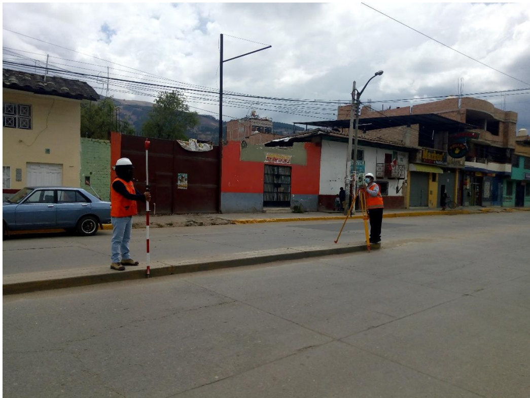
Fotografía 10: Toma de datos del levantamiento topográfico.
