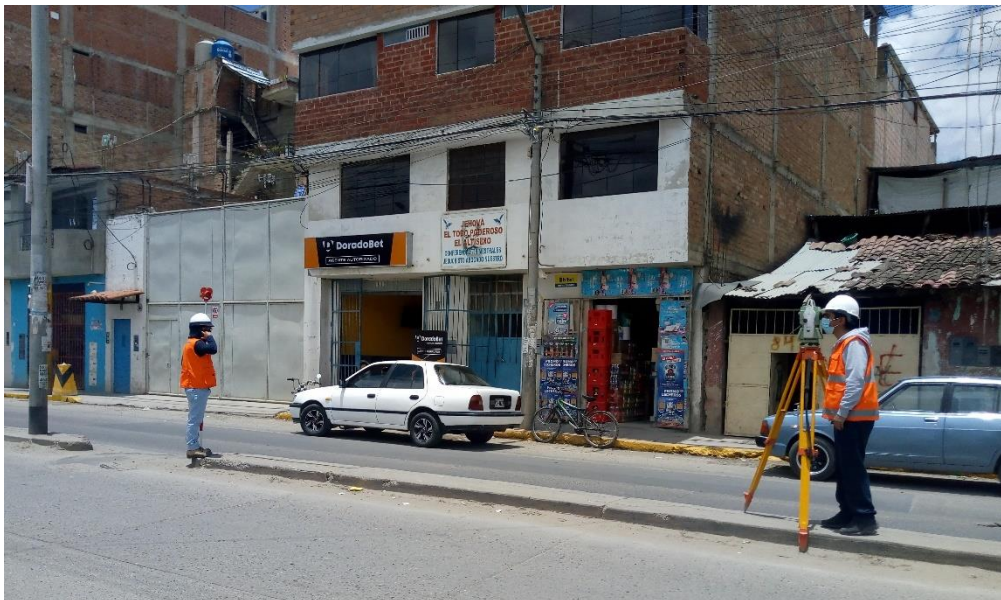
Fotografía 8: Se hizo el levantamiento topográfico de dicho tramo de vía.
