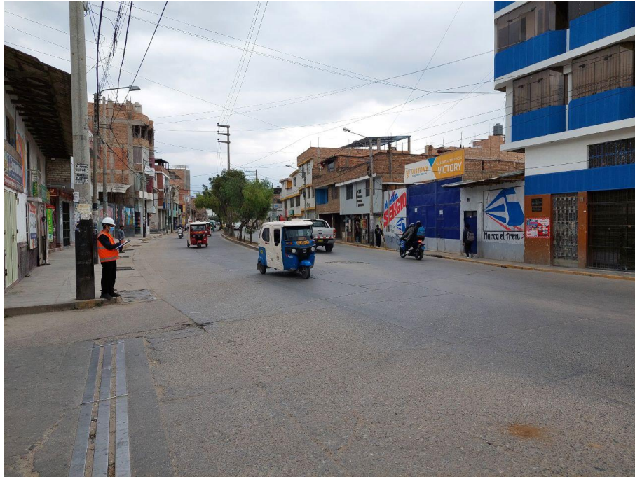
Fotografía 3: Toma de datos del segmento en la dirección de viaje I de la Av. San Martín.
