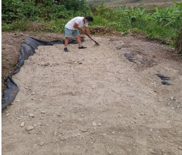
**FOTO N° 2:** Vista del proceso constructivo del humedal. Se parecía la colocación de una capa de tierra agrícola sobre un sustrato de grava.
