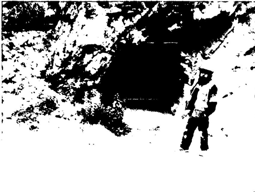
**FOTO 34:** Vista del muro ya construido que servirá como tapón para la bocamina.
