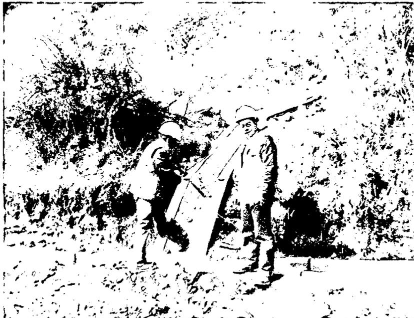
**FOTO 43:** Verificación de las medidas de la canaleta que evacua el agua proveniente de la bocamina.
