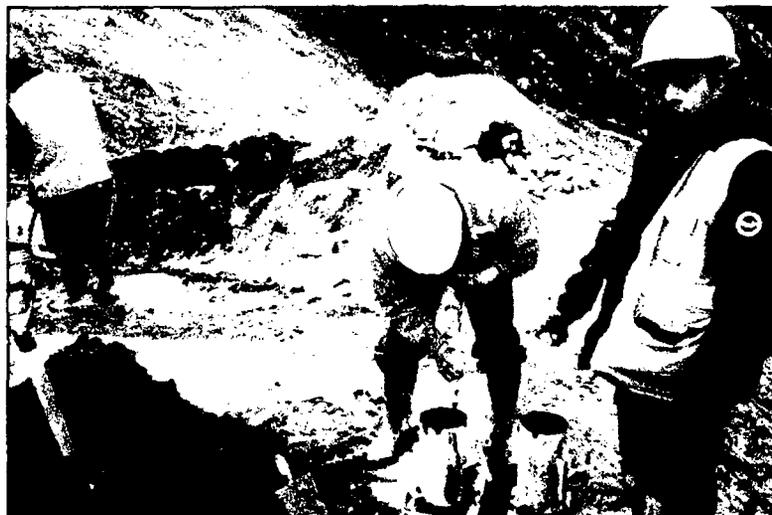
**FOTO 12:** Sacando probetas para verificar la calidad del concreto.
