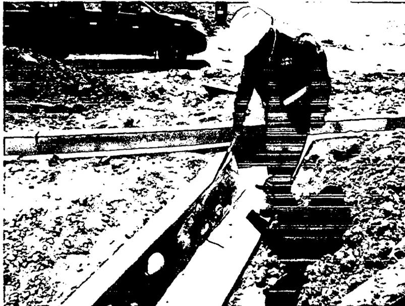
**FOTO 42:** Verificación de las medidas de la canaleta que evacua el agua proveniente de la bocamina
