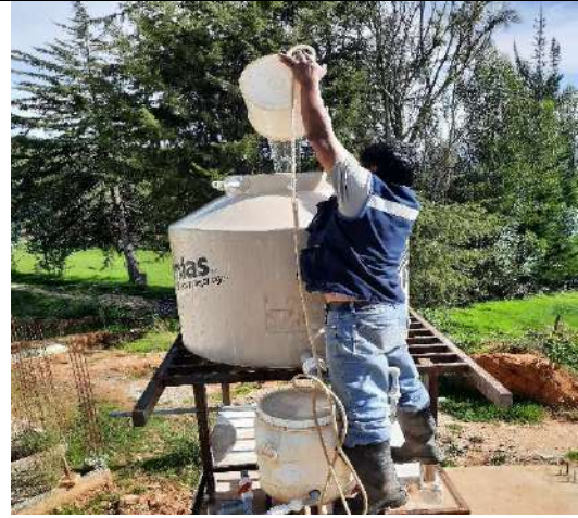
Fotografía N° 06: Cloración del agua
