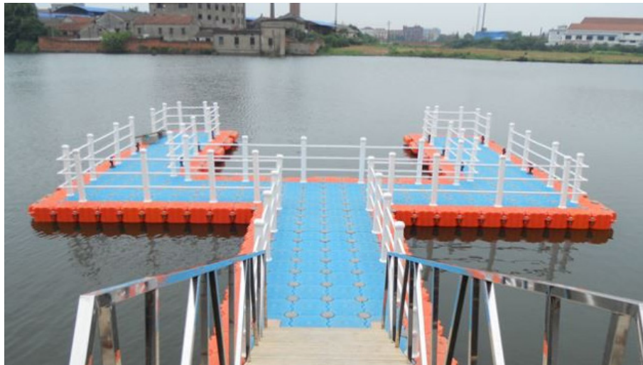
Plataforma flotante de polietileno
