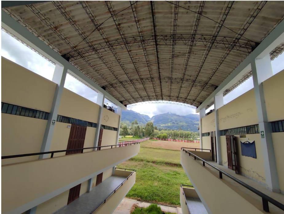
Fotografía N° 5 Inspección in situ
