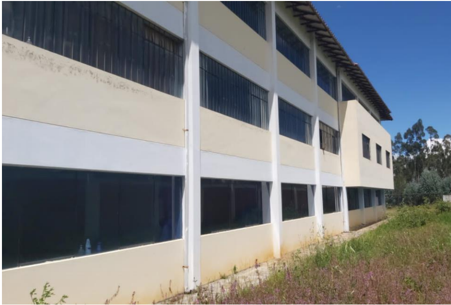
Fotografía N° 3 Vista lateral izquierda del edificio UNC Sede Cajabamba
