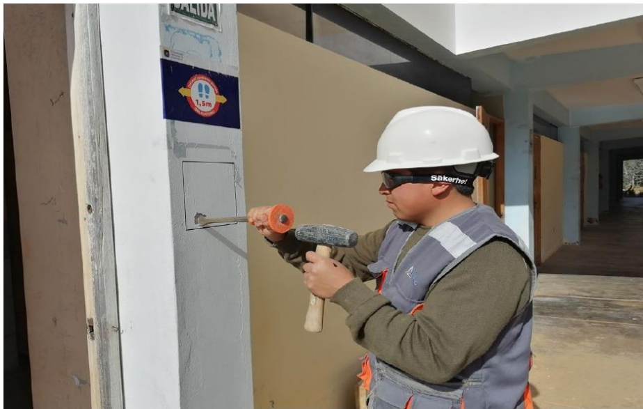
Fotografía N° 8 Preparación de la superficie para ensayo de esclerometría
