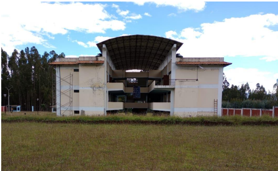
Fotografía N° 2 Vista posterior del edificio UNC Sede Cajabamba
