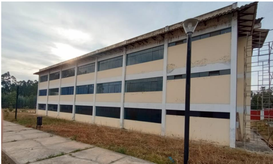
Fotografía N° 4 Vista lateral derecha del edificio UNC Sede Cajabamba
