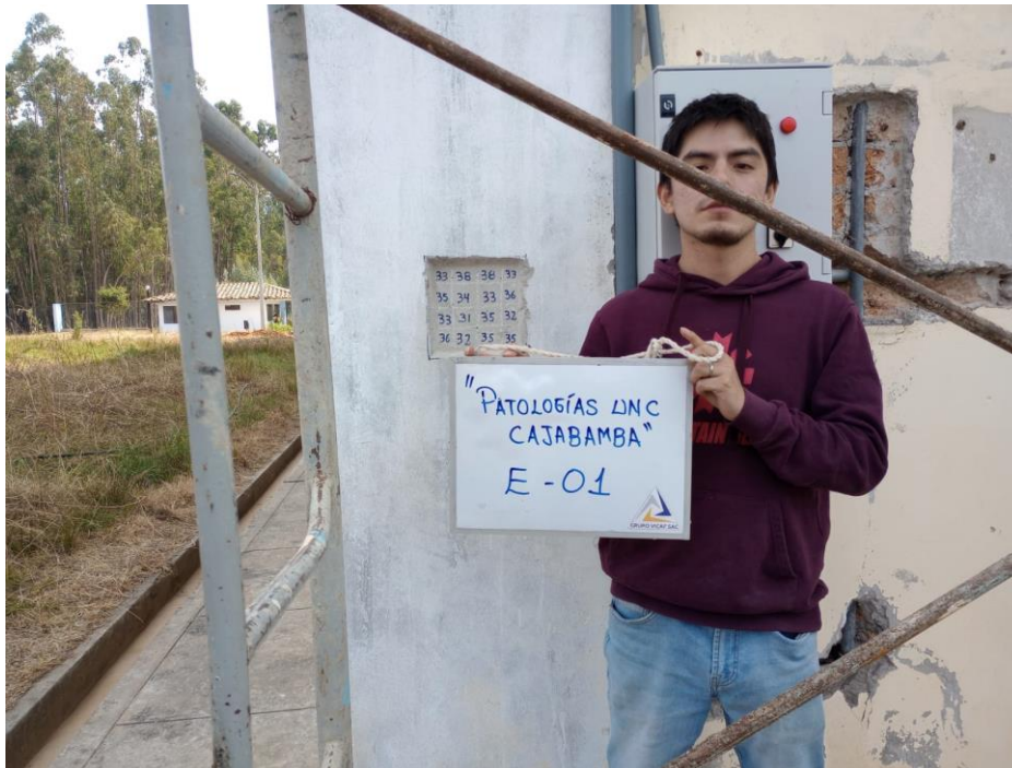
Fotografía N° 9 Punto de Esclerometría E-01 (Columna)
