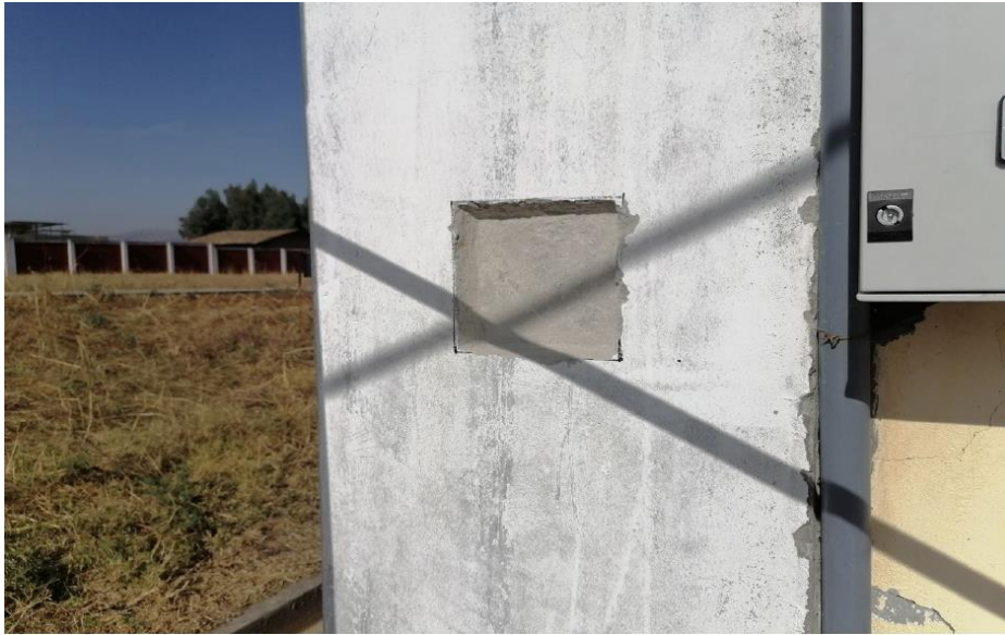
Fotografía N° 7 Preparación de la superficie para ensayo de esclerometría
