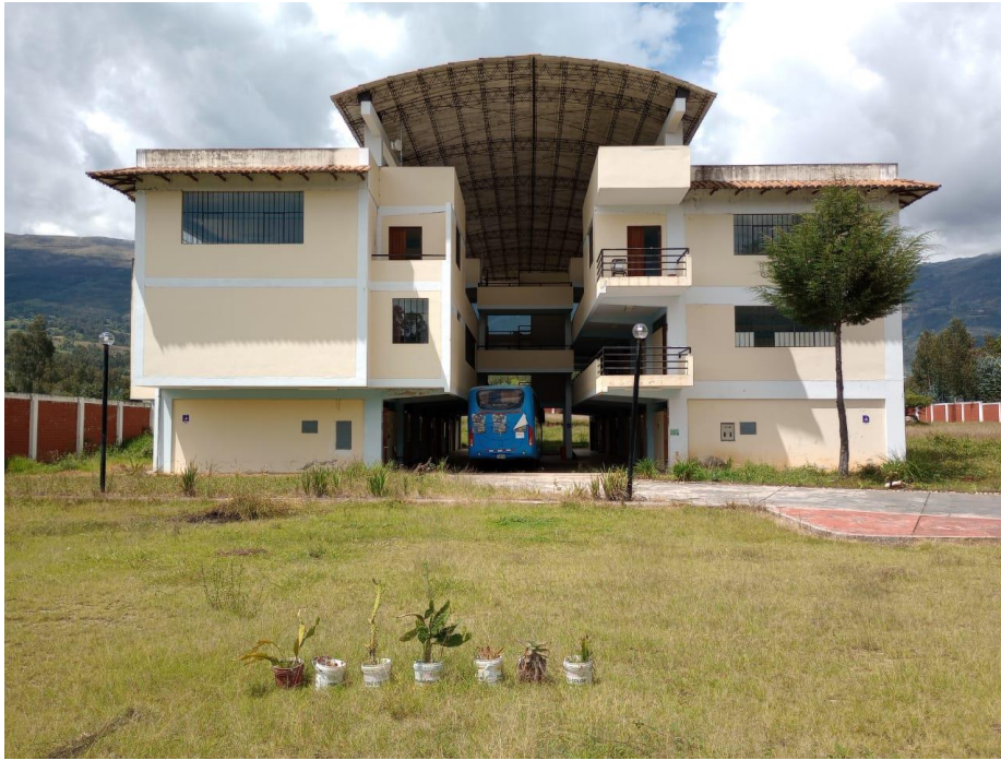
Fotografía N° 1 Vista frontal del edificio UNC Sede Cajabamba
