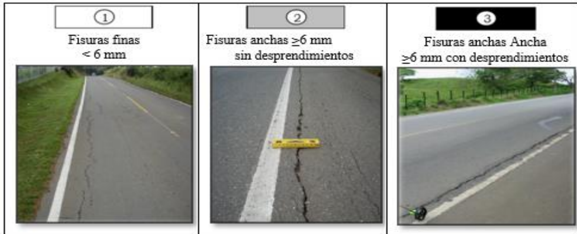
Figura 2. 11. Niveles de gravedad fisura de borde
