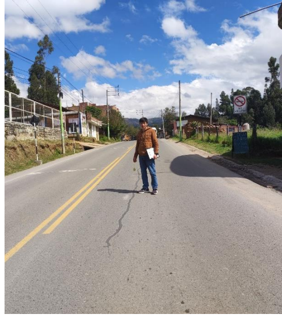
Fotografía 14: Deterioro superficial en el carril derecho de la progresiva 7+500.00 - 7+600.00 deterioro fisura longitudinal por fatiga M-16
