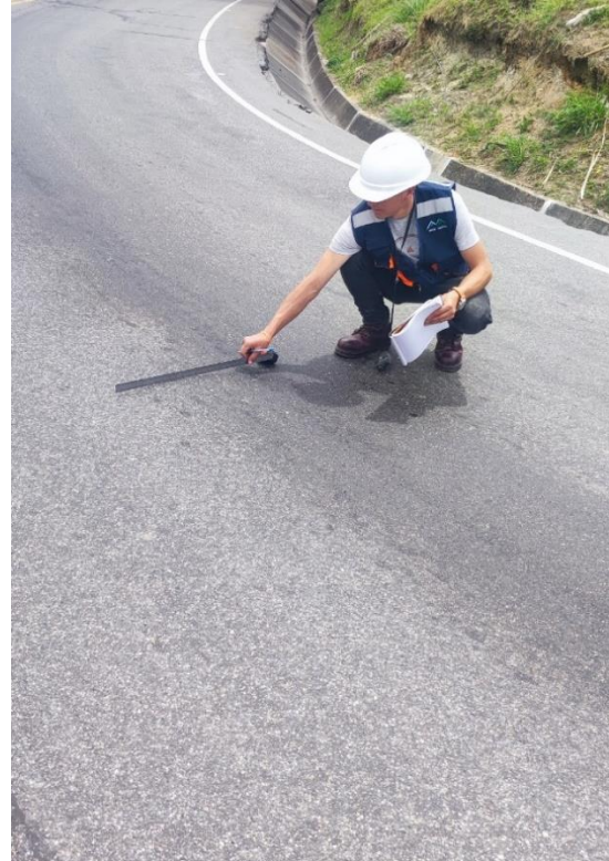
Fotografía 26: Deterioro superficial en la progresiva Km: 10+800.00 - 10+900.00 deterioro Ahuellamiento (AH) M-49
