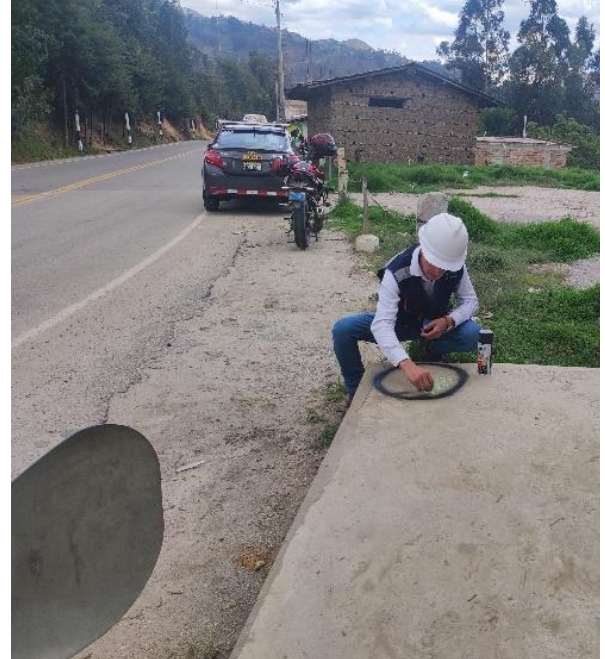
Fotografía 6: Grabación y demarcación de un punto característico en la zona del levantamiento topográfico.
