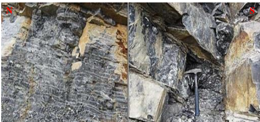
Figura 7. Calizas oscuras bituminosas bien estratificadas de la Formación Pariatambo con coordenadas E: 761099, N: 9253126.
