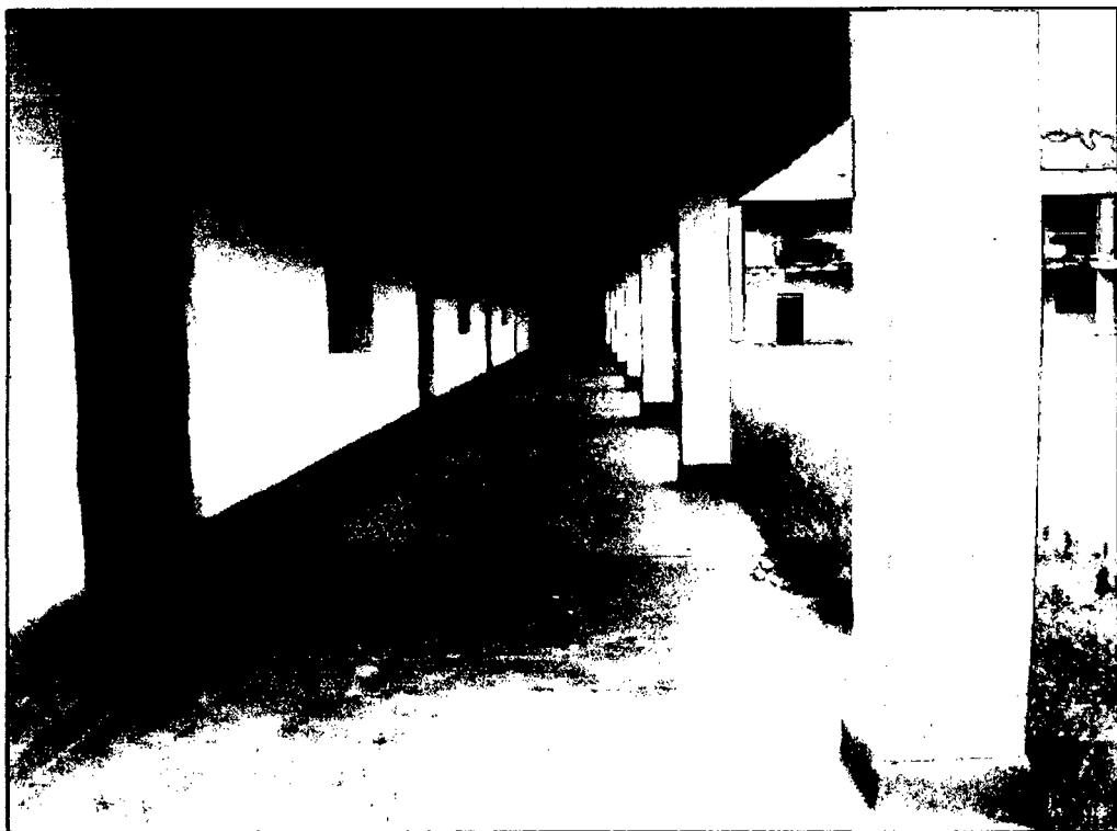
Pabellón Aulas de la I.E. José Gálvez de Huacapampa – Celendín, (Pabellón 02).
