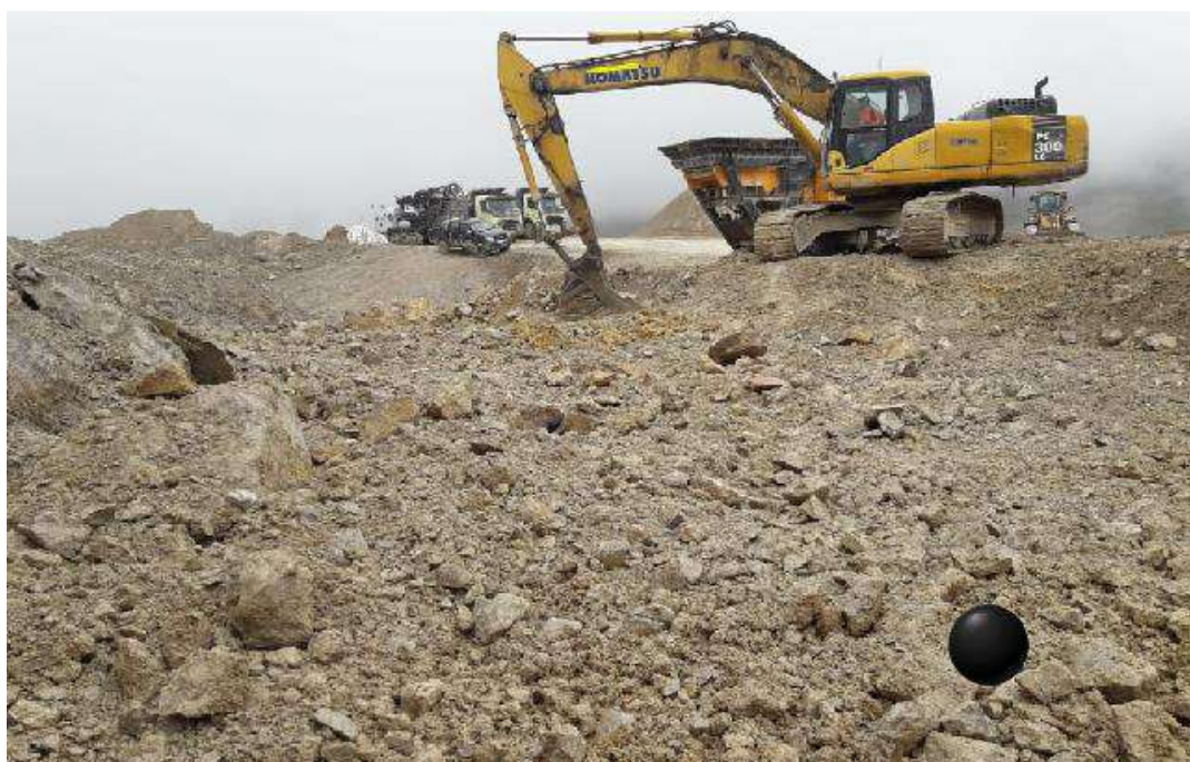
Foto 6. Fragmentación post voladura y comparación con la esfera de color negro de 9.8 pulgadas.
