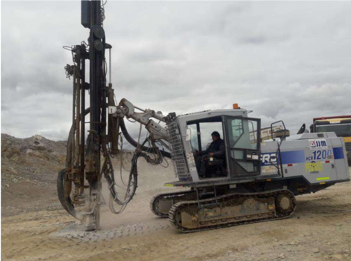
Foto 4. Trabajos de malla de perforación 1.8 m x 1.8 m con Perforadora HCR1200-EDII.
