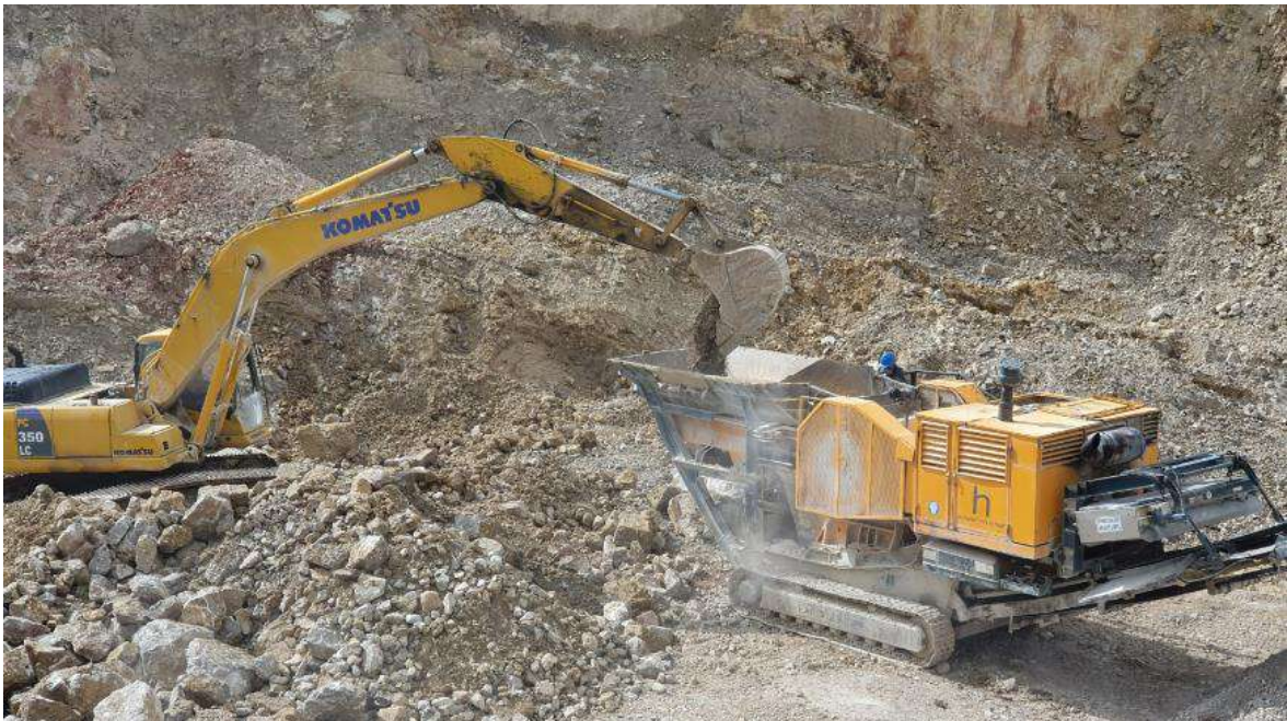
Foto 1. Excavadora Komatsu PC 350 LC.
