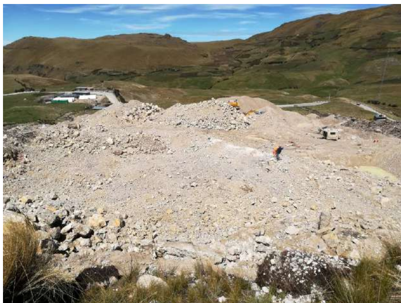
Foto 3. Zona de perforación y voladura.
