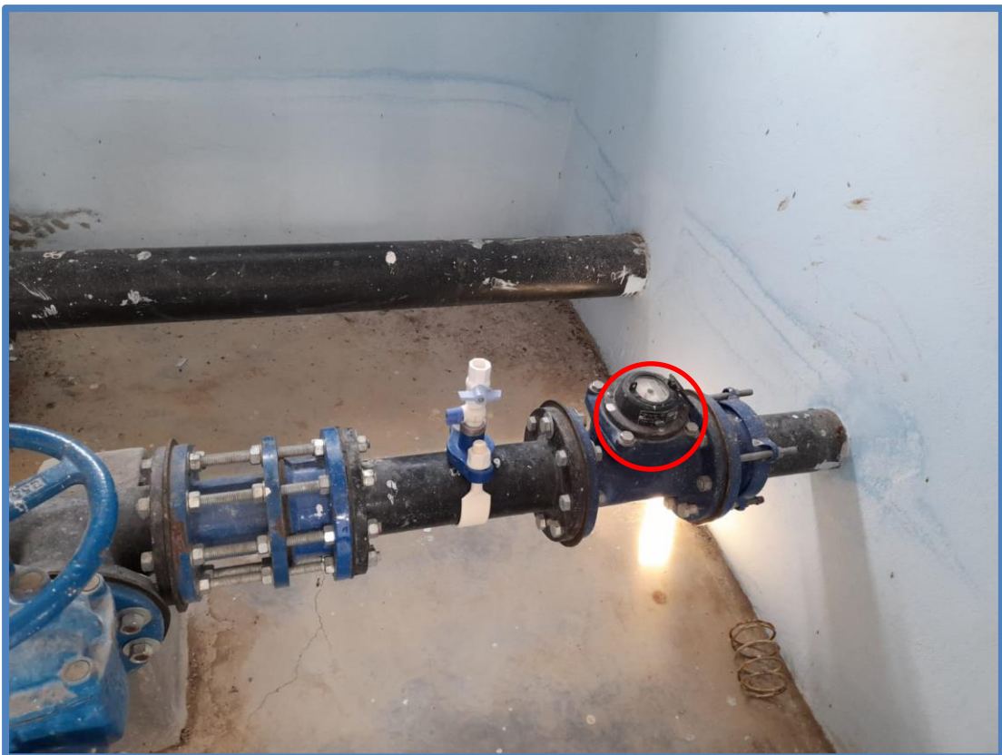
Foto 4: Ubicación del macromedidor en el reservorio.
