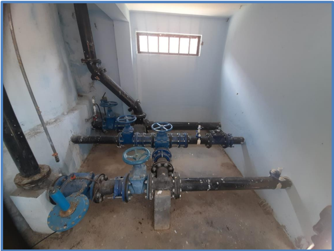
Foto 4: Ubicación del macromedidor en el reservorio.
