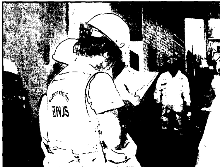
Fotografía 19. Verificación y aprobación de la prueba hidráulica por el ingeniero supervisor, y firma del protocolo.
