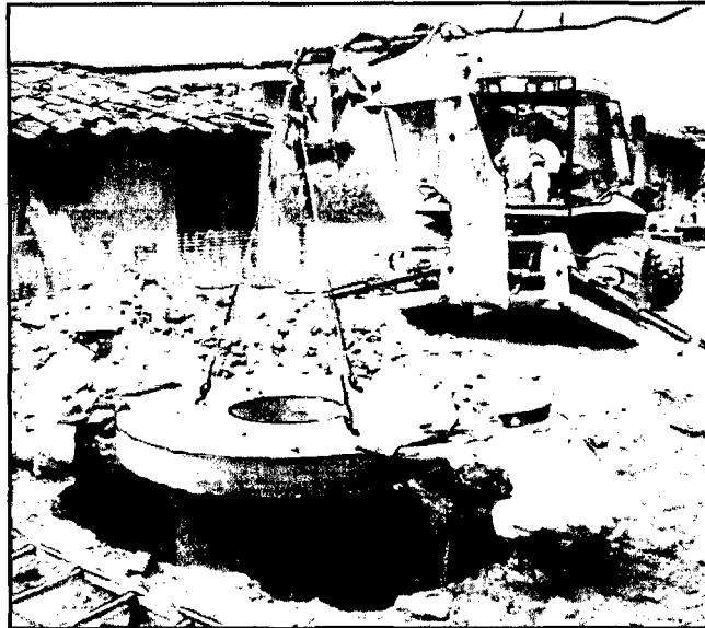
Fotografía 16. Instalación de buzón prefabricado
