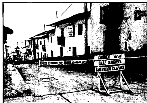
Fotografía 7. Señalización instalada en obra
