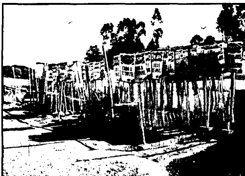
Fotografía 6. Señalización para ser instalada en obra
