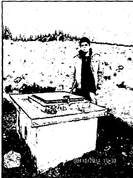
FOTO N°19: Ubicación Cámara Rompe Presión Tipo 6
