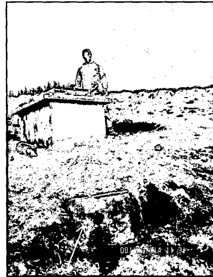
FOTO N°20: Dado Móvil de Concreto de la CRP-TIPO 6
