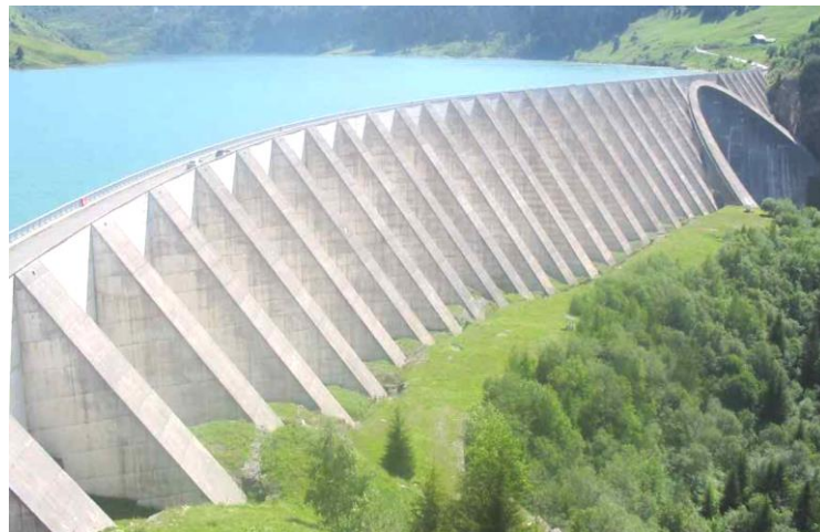
Foto 1: Presa de contrafuerte Roselend, Savoie, Francia. Fuente: Tomado de Versegui, (2007), citado por Sandoval, (2018).
