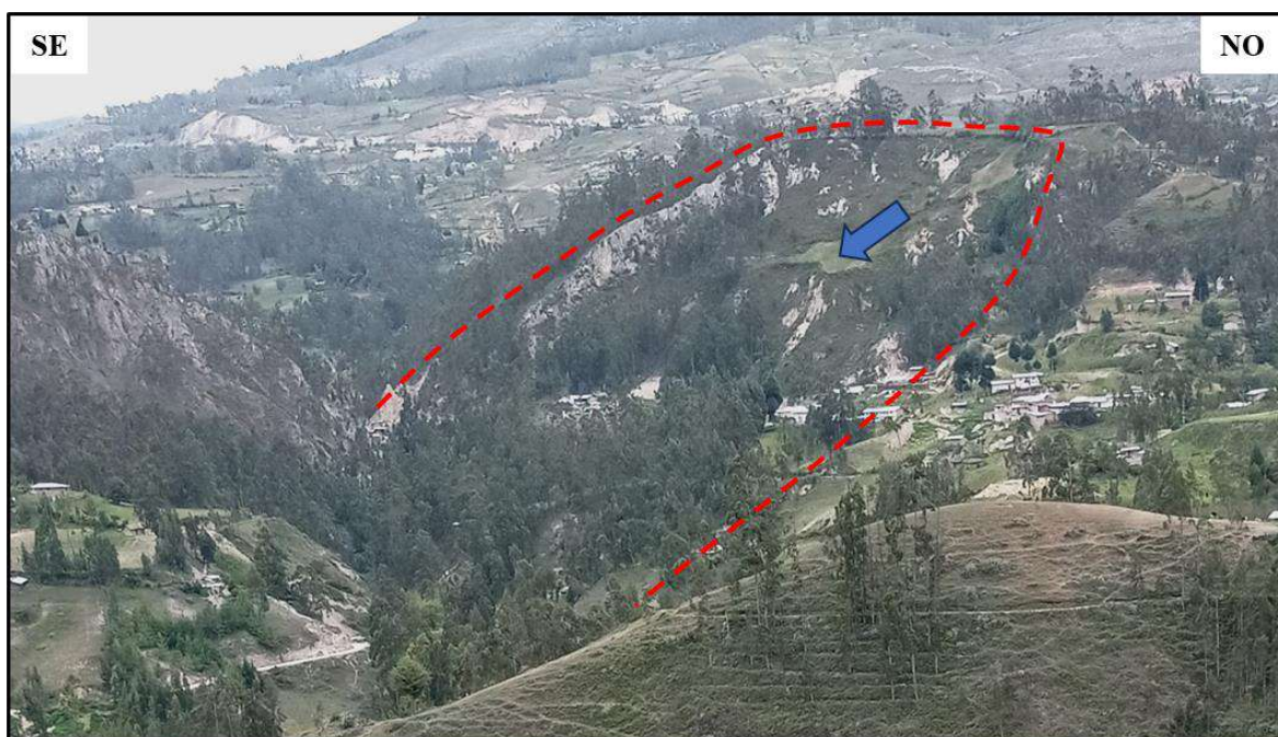
Foto 13. Deslizamiento rotacional progresivo y retrogresivo sobre el Volcánico Huambos.
