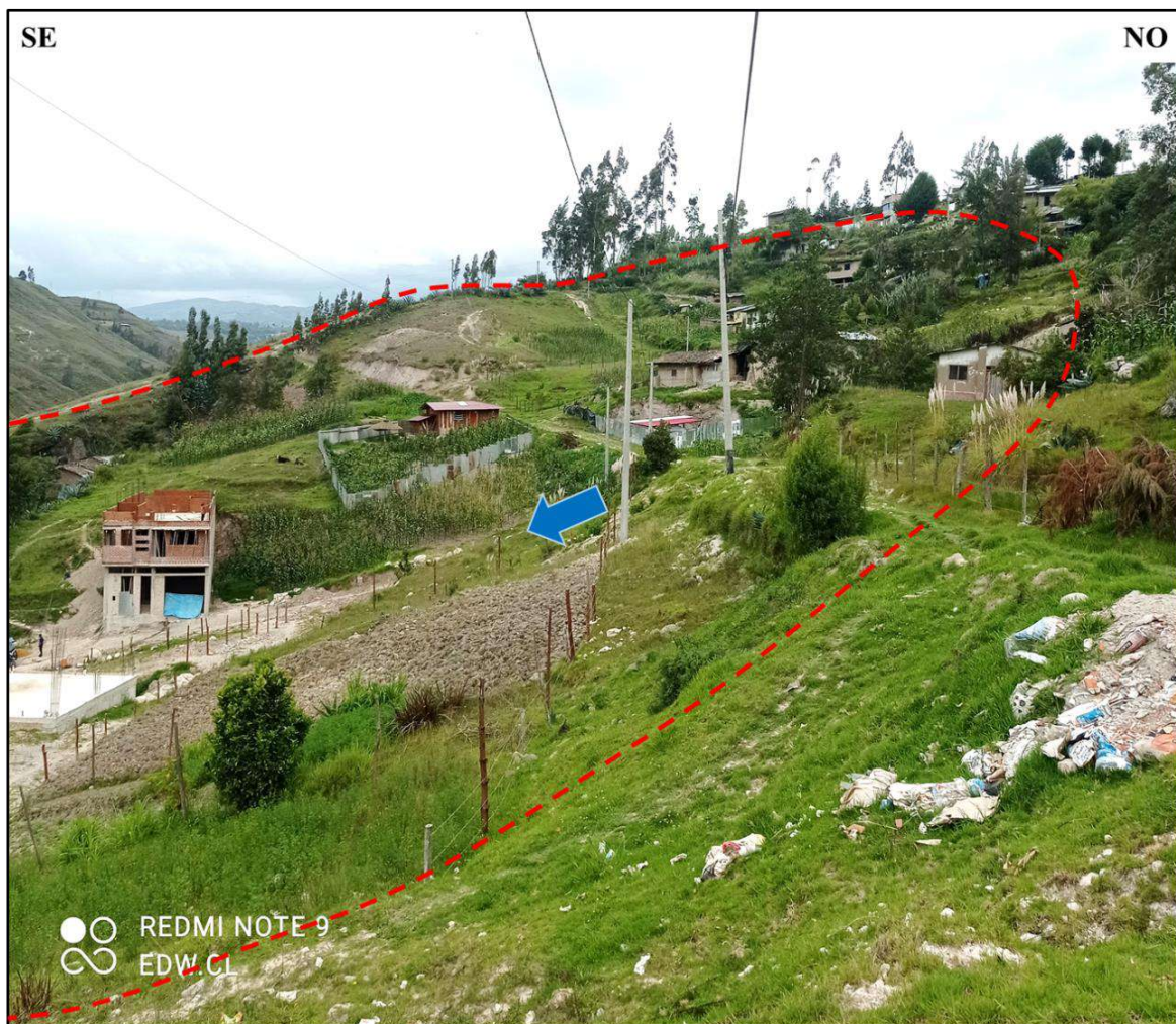
Foto 15. Paleodeslizamiento rotacional sobre el Volcánico Huambos y viviendas construidas sobre el cuerpo principal del paleodeslizamiento.
