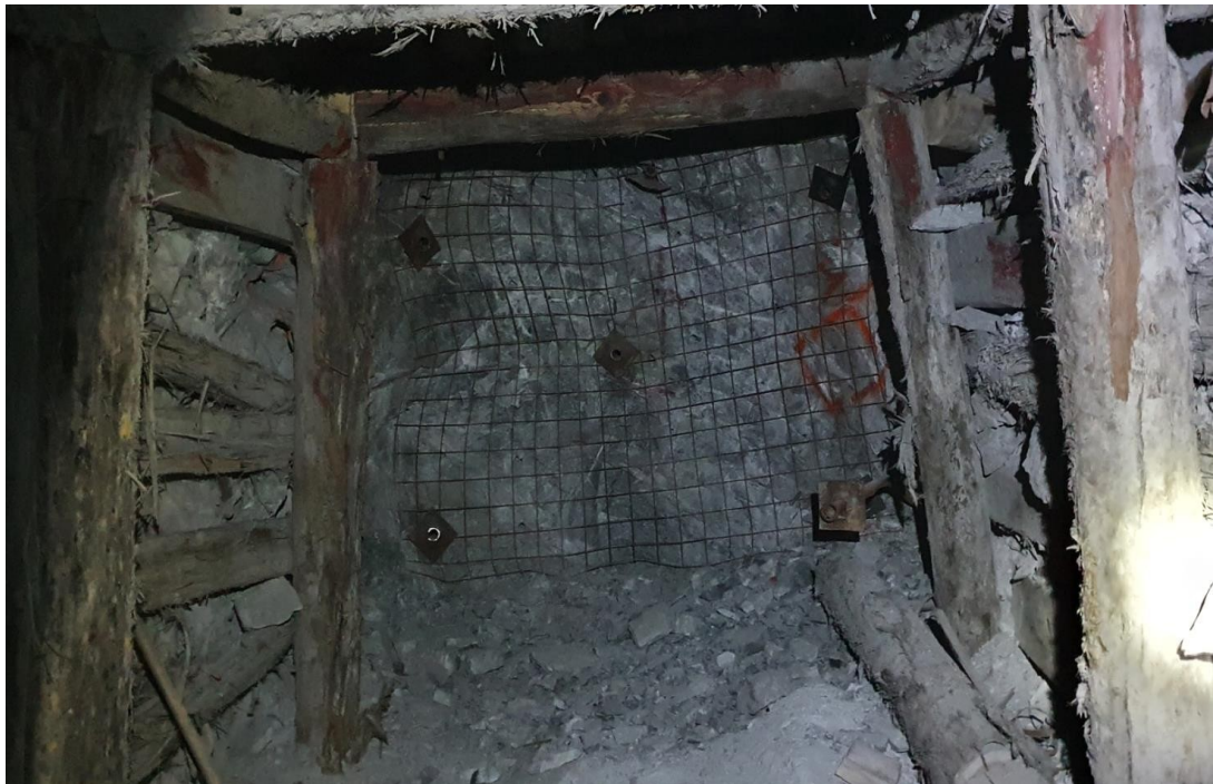
Foto 10: Sostenimiento de sacrificio en chimenea inclinada 45° RC 05- Nivel 04.
