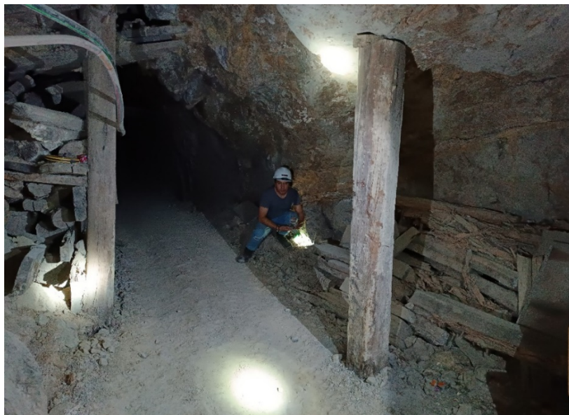
Foto 1. Bocamina del Nivel 4 inicio de las instalaciones: Crucero 1040 NE y Bay-pass.
