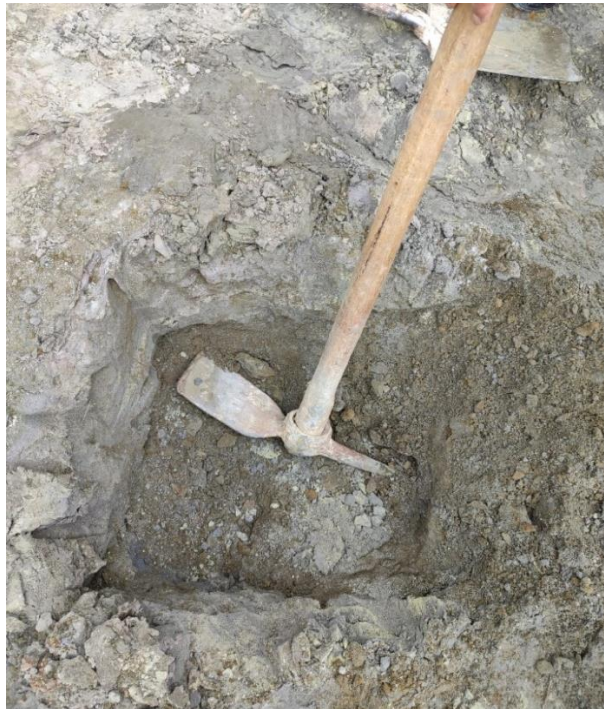
Foto 10. Limpieza de calicata en el relave minero La Tahona.
