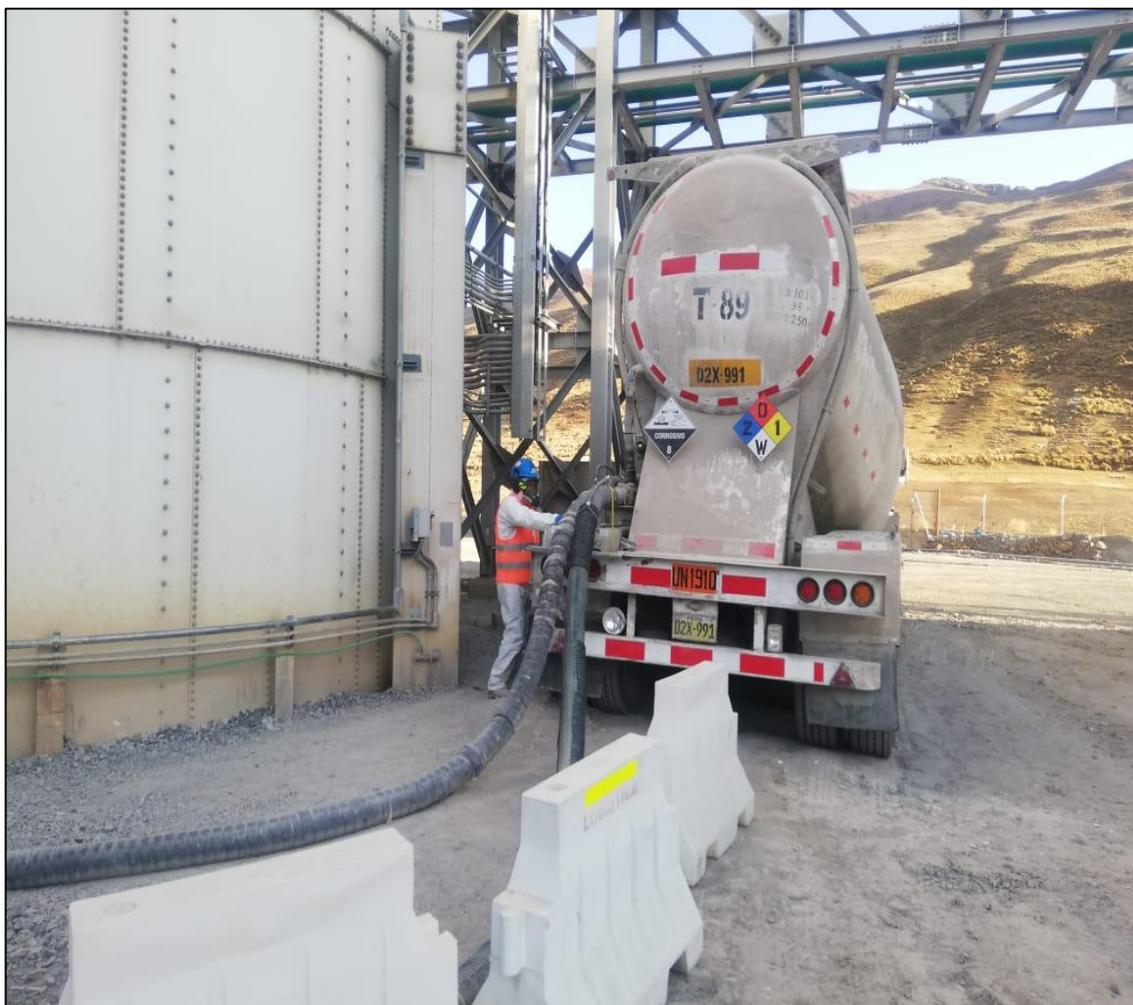
**Anexo 05: Conexión de acoples para la descarga a través de aire**
