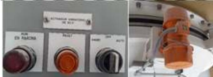
**Una vez llena la bombona se activa el sensor de nivel, mediante una alarma sonora, el cual está indicado en el panel de control con un botón de color azul permitiendo el cierre automático de la válvula cuchilla del silo.**
