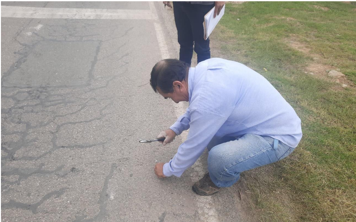
Fotografía 8. Perforación para el ensayo con Viga Benkelman en la carretera Cajamarca-San Marcos; Tramo Iscocongá (Plaza Pecuaria)- Llacanora
