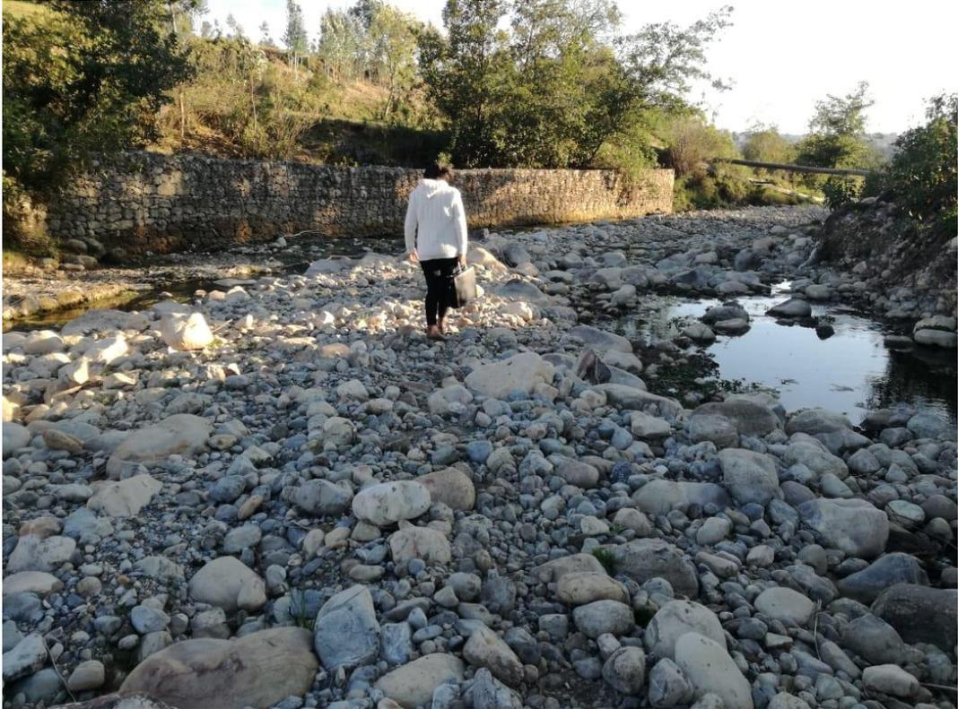
**Figura 63:** Cauce natural del río La Quispa y presencia de gaviones (foto tomada 14/12/2022)
