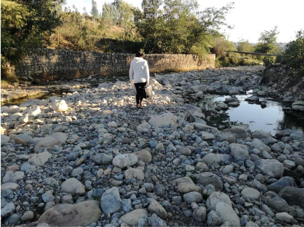
**Figura 45:** Presencia de gaviones y colmatación de materiales en el río La Quispa (foto tomada 19/11/2022)
