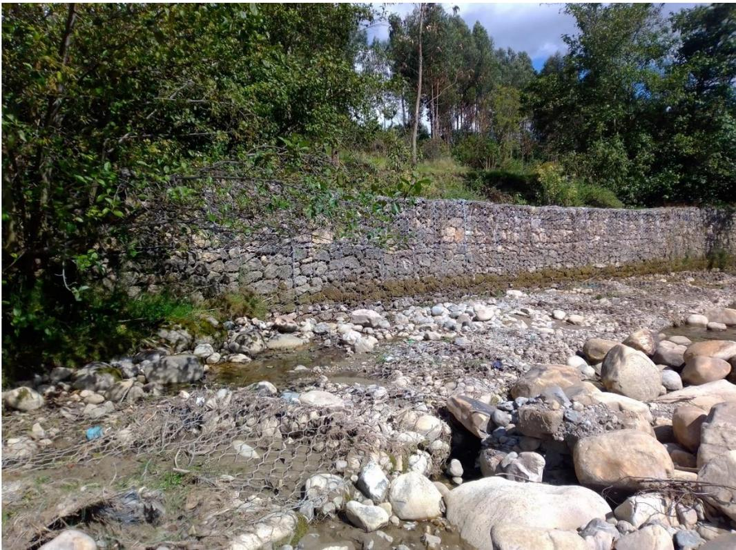
**Figura 72:** Presencia de gaviones en el cauce del río La Quispa (foto tomada 18/04/2023)
