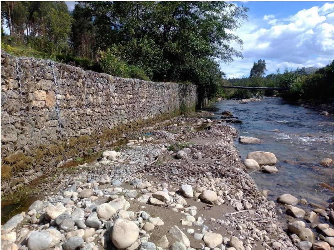
**Figura 39:** Presencia de gaviones a orillas del río La Quispa. (foto tomada 18/04/2023)
