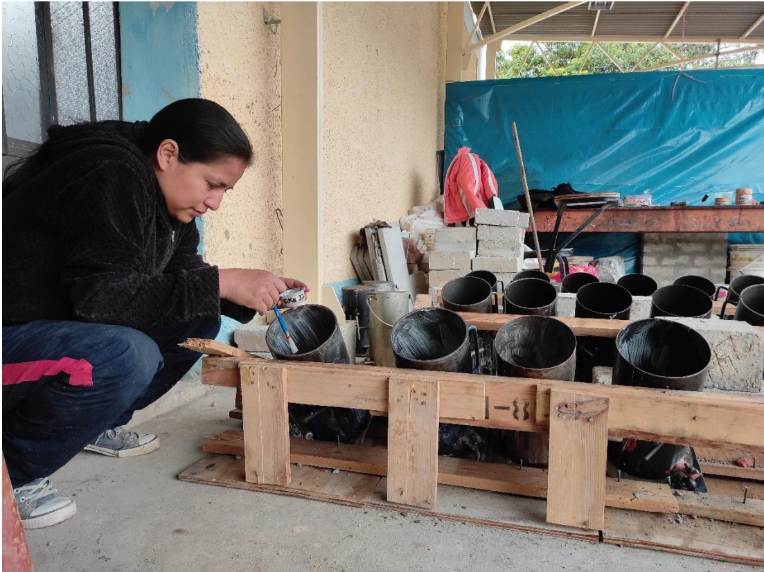
Figura 85: Colocación de Epóxico Sika 32 en las juntas de construcción
