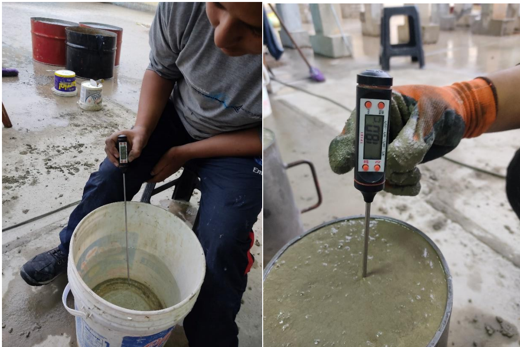
Figura 76: Verificación de temperatura en el agua y concreto
