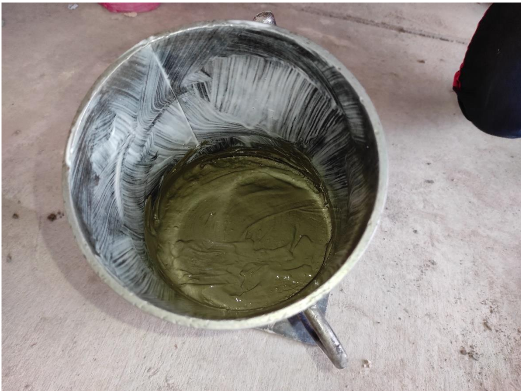
Figura 45: Lechada de cemento y agua en junta de 0°
