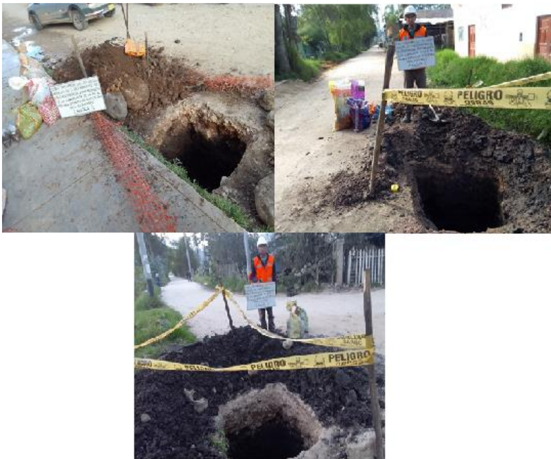
Figura N° 12: Excavación de calicatas y muestreo de suelos
