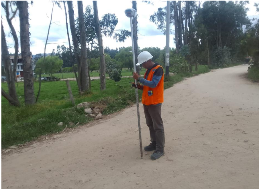
Figura N° 11: Toma de puntos topográficos.
