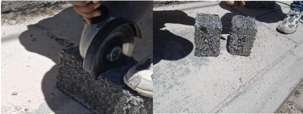
**Figura 27:** Acerrado del ladrillo de PET y cemento para la construcción de los módulos de 50cmx50cmx50cm.
