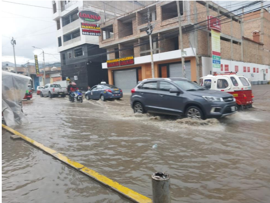
Foto N° 9: Impedimento al drenaje
