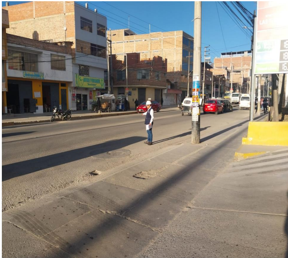
Foto N° 3: Identificando el sentido de los caudales en las calles
