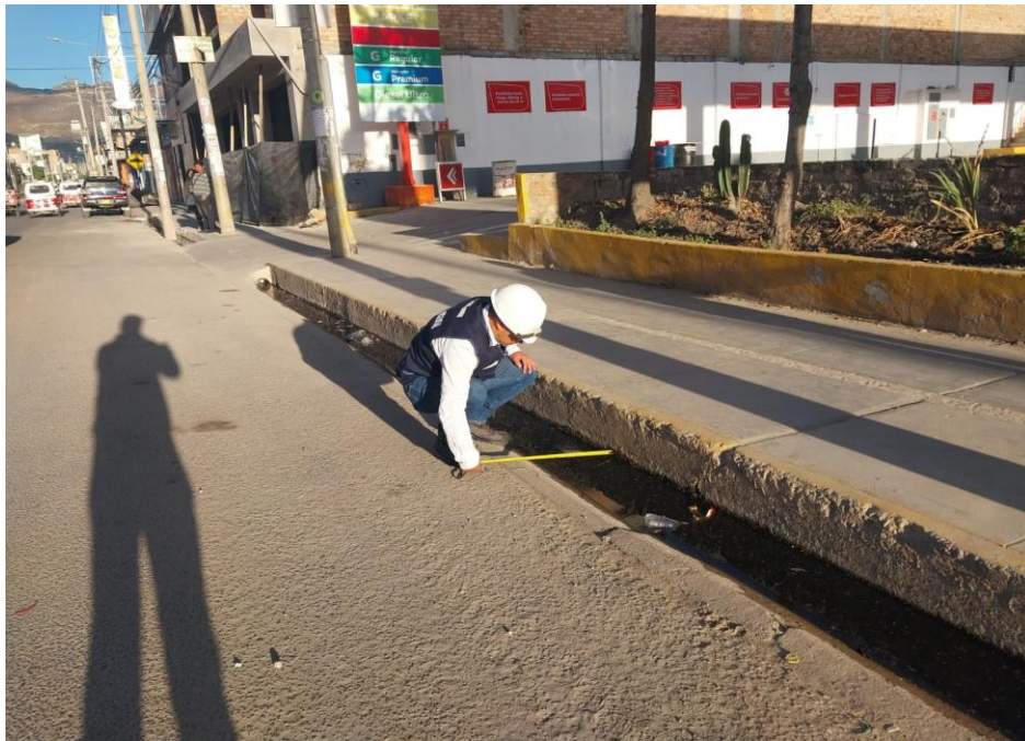
Foto N° 1: Tomando medidas de cuneta
