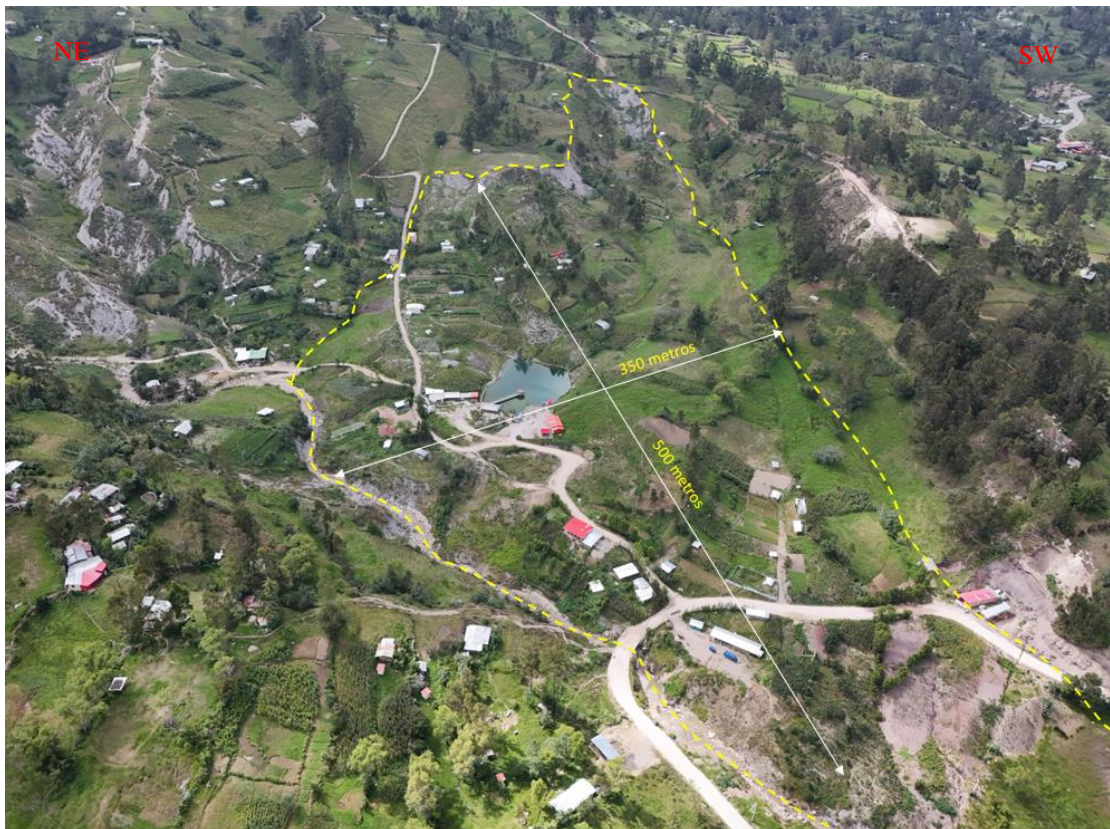
Foto N°: 25: Morfometría del deslizamiento Coordenadas: E: 761438.99 N: 9273867.24 C: 2466 m.s.n.m
