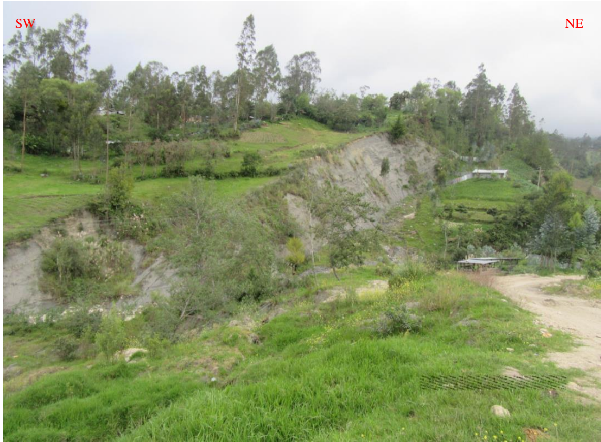
Foto N°: 11: Vertiente con depósito de deslizamiento Coordenadas: E: 761662.34 N: 9273879.55 C: 2492 m.s.n.m.
