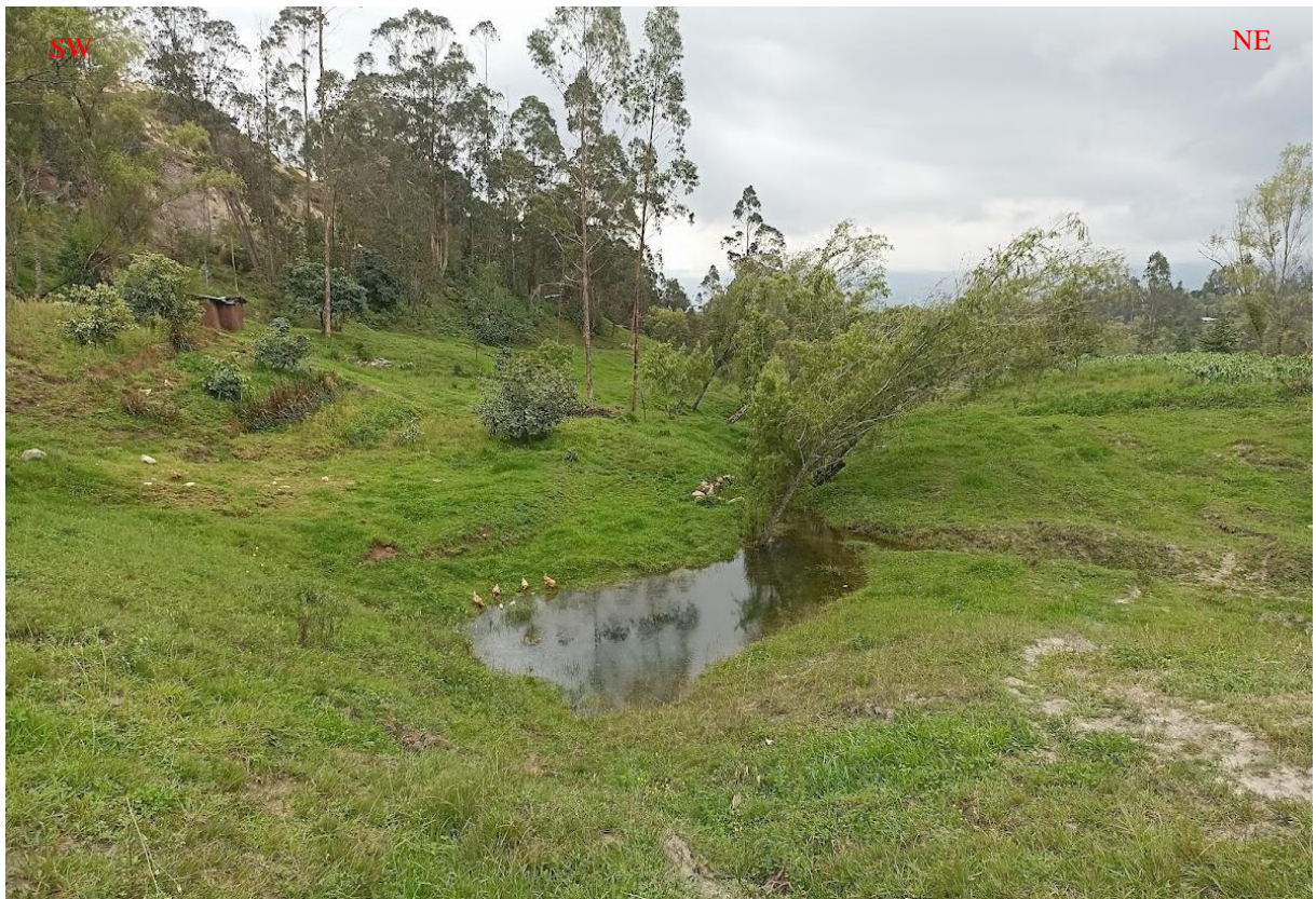
Foto N°: 24: Inclinación de los arboles por la reptación de suelos existente Coordenadas: E: 761582.30 N: 9273559.47 C: 2511 m.s.n.m.
