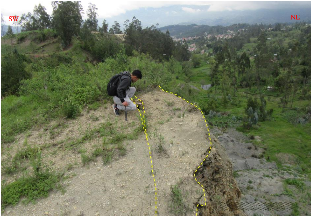
Foto N°: 23: Agrietamiento en la corona del deslizamiento al SW de la alguna del amor Coordenadas: E: 761829.42 N: 9273305.70 C: 2550 m.s.n.m.
