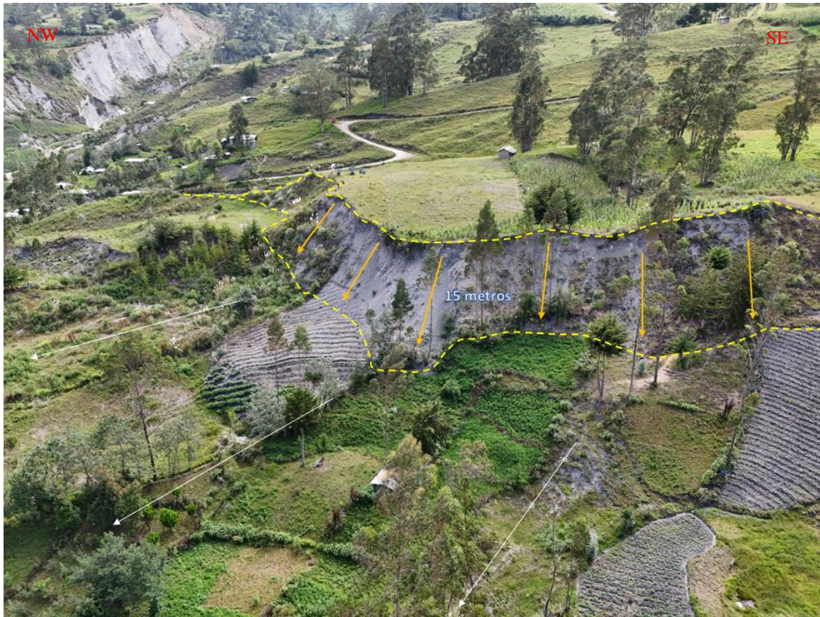
Foto N°: 26: Altura del escarpe principal Coordenadas: E: 761837.34 N: 9273360.48 C: 2445 m.s.n.m.
