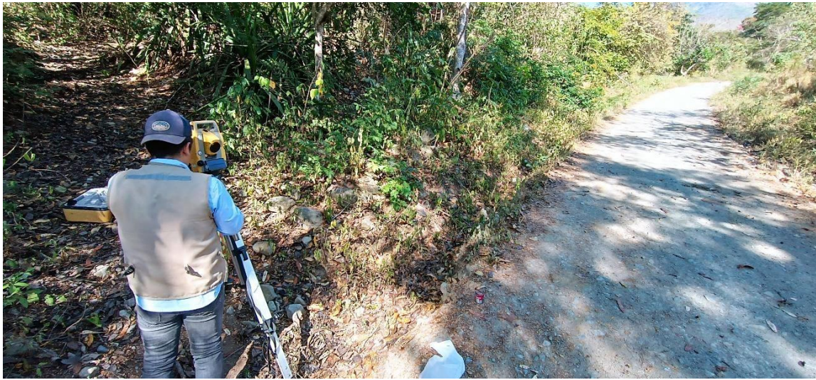
Foto 1: configuración de estación total para iniciar con el levantamiento topográfico de la carretera Cruce El Muyo, Caserío Yucarica, El Puquio, distrito de Chirinos, Provincia de San Ignacio – Cajamarca.
