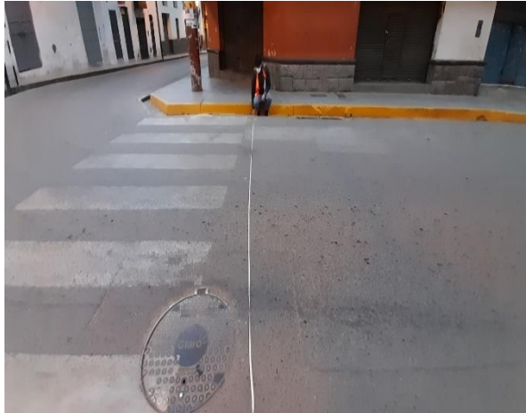
Descripción: Midiendo el ancho de la calzada en el Jr. Del Comercio Cdra. 06.
