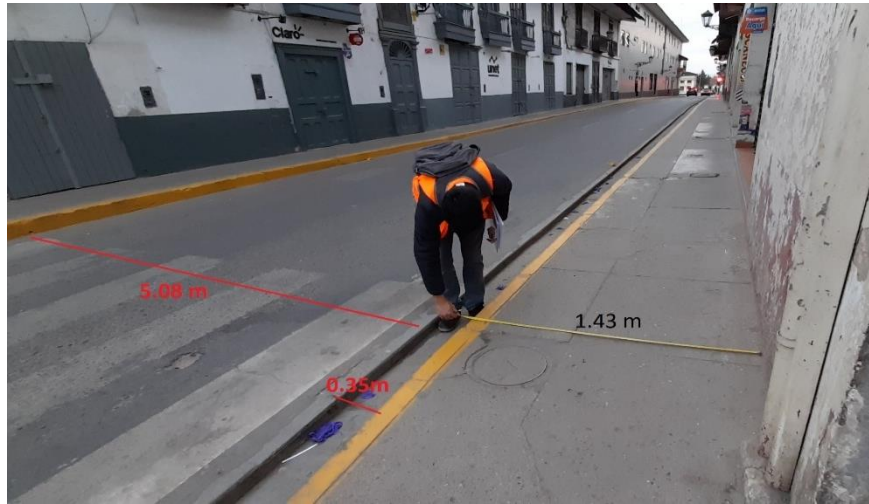
Figura N° 4.17. Infraestructura vial de Jr. Del Comercio Cdra. 07.
