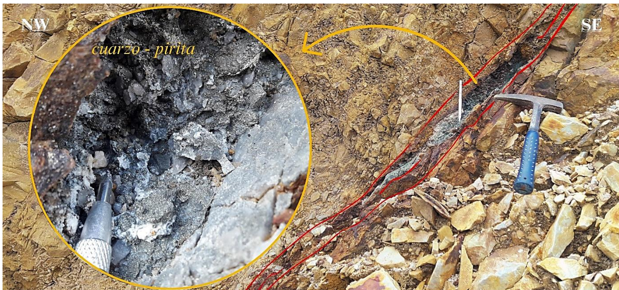
Foto 15. Veta de la Cantera San Cirilo emplazada en areniscas de la Fm. Farrat. Dirección N190^\circ Y buzamiento 42^\circ NW. Coordenadas fotográficas: N: 9236184 y E: 764416
