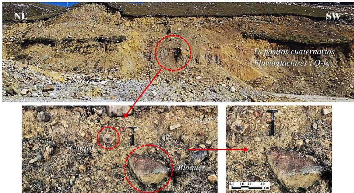
Foto 4. Cuaternario Fluvioglacial en el corte de la Cantera Quebrada Honda, presenta gravas cantos y bloques subredondeados no consolidados de más de 25 cm de diámetro en una matriz limosa.
